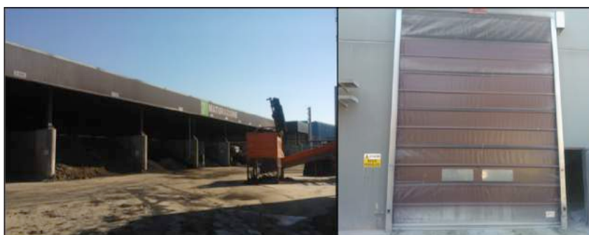
Figura 7.20: Area di deposito/maturazione (sinistra), portellone del magazzino di stoccaggio materiale inertizzato (destra).
