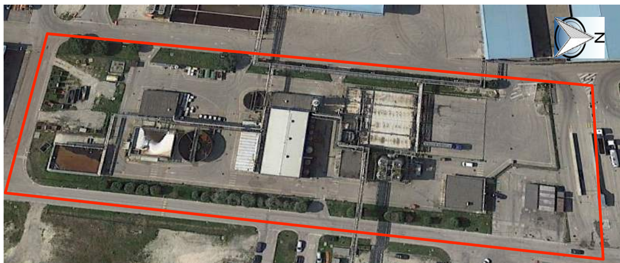
Figura 7.9: Impianto di trattamento chimico-fisico (TCF).
