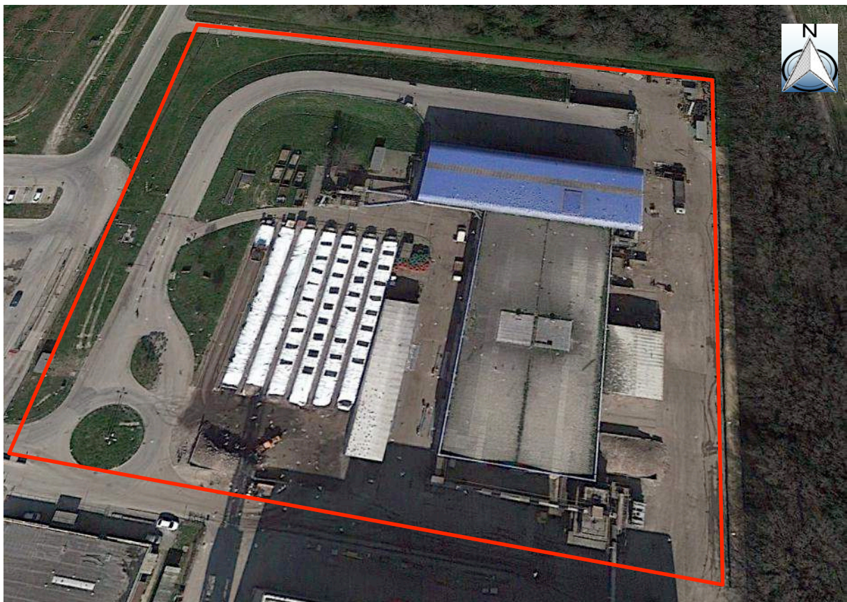
Figura 7.6: Impianto di produzione CSS e biotunnel.
