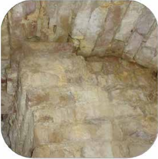
Deposito stratiforme, compatto e aderente al substrato, composto da sostanze inorganiche di origine calcarea.
