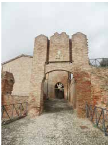
Fronte della porta di ingresso
