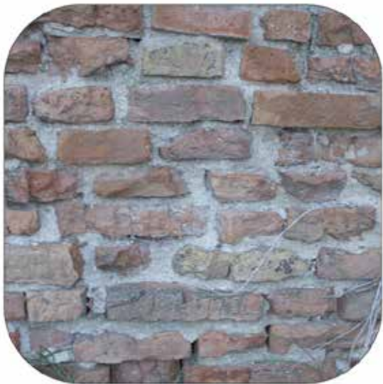
Ristilatura dei giunti con malta cementizia di presumibile fattura post-bellica.
