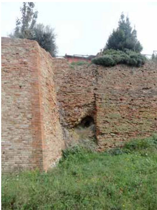
Fig. Canale di scarico Ovest
