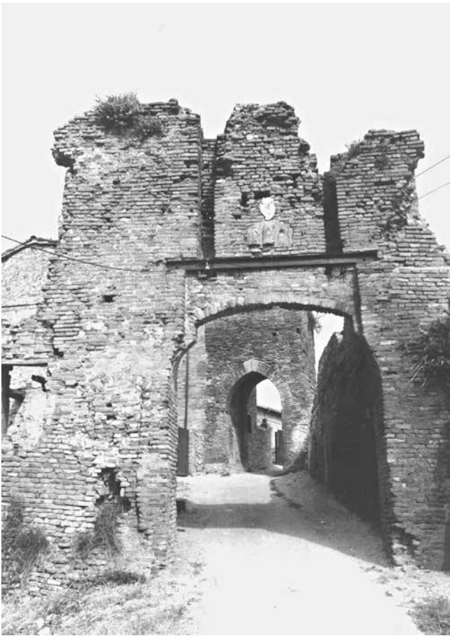
Fig. 16 L'edificio tra le due porte allo stato attuale
