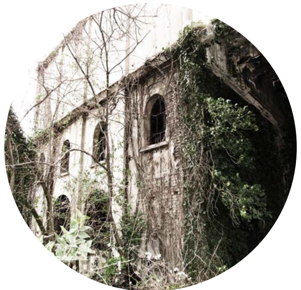
Fig.98 La facciata dell'edificio dei macchinari
