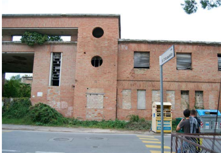
Fig.175 Vista edificio portale da via Marconi
