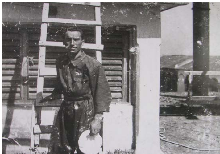
Fig.65 Operaio al lavoro, sullo sfondo la ciminiera
