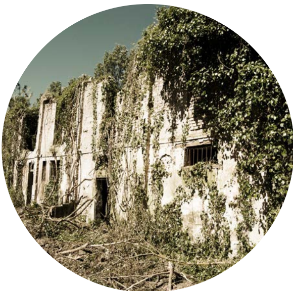
Fig.99 Edificio dei salariati su via Fattori
