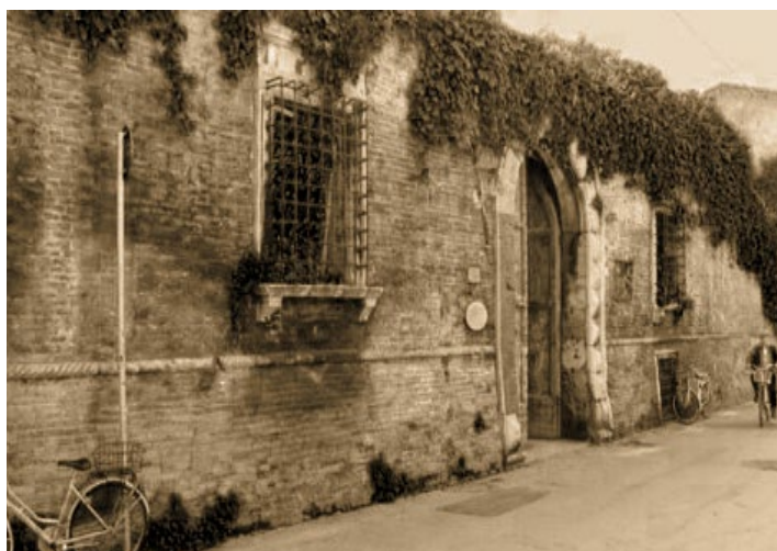
Fig. 27 Palazzo Lettimi oggi, l'edificio è stato pesantemente bombardato durante la Seconda Guerra Mondiale
