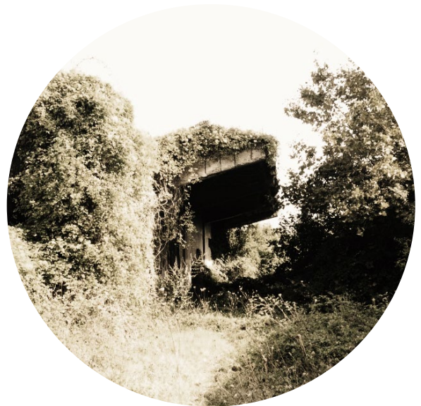
Fig.77 Veduta del deposito avvolto nella vegetazione
