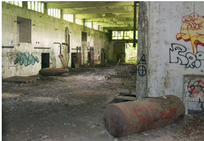
Fig.185 Reparto di essiccazione
