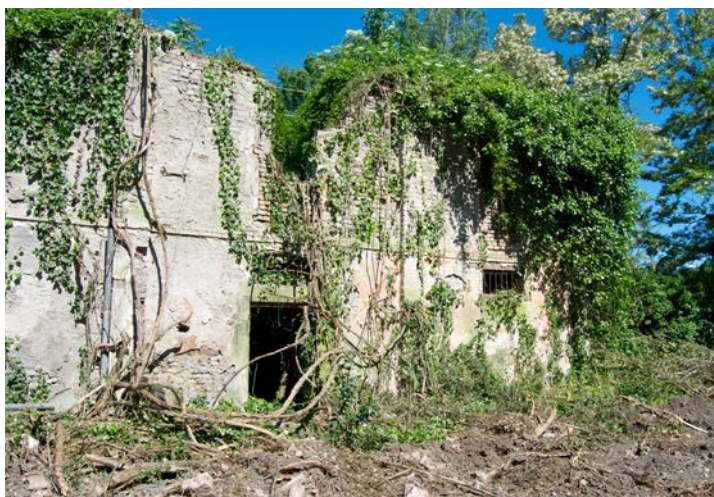
Fig. 196 Vista dell'edificio dall'interno dell'area
