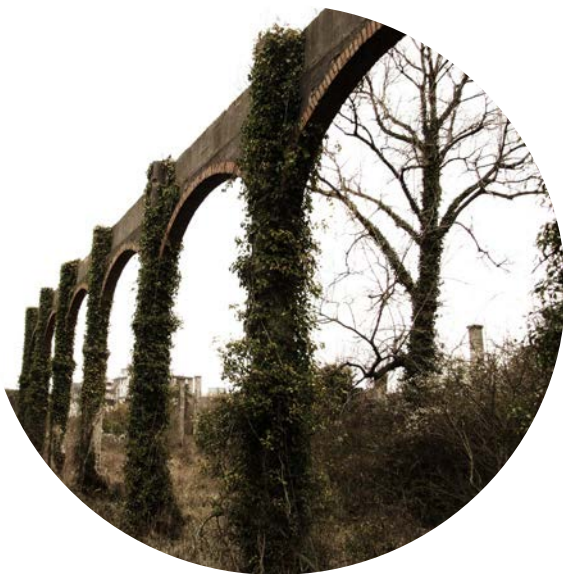
Fig.88 Parete intatta di un deposito crollato durante i bombardamenti
