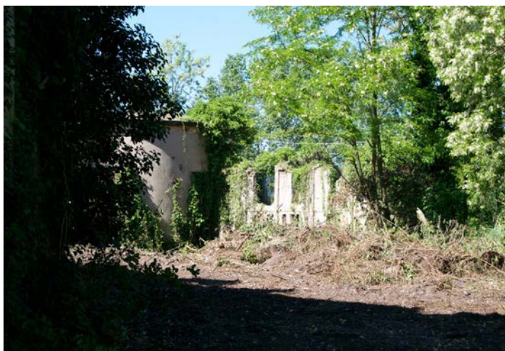
Fig. 195 Vista dell'edificio dall'interno dell'area
