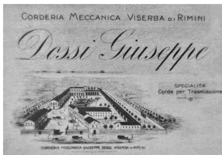
Fig.56 Cartolina raffigurante la Corderia Meccanica di Dossi Giuseppe a Viserba di Rimini, 1911
