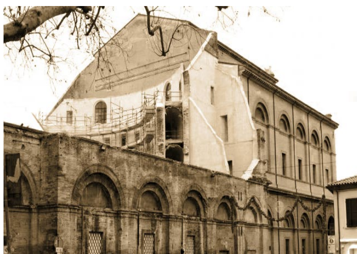
Fig. 21 Teatro Galli oggi, si notato le impalcature per i lavori di ristrutturazione. I crolli sono stati causati dai bombardamenti del '43
