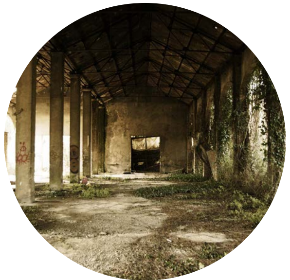
Fig.87 Interno del deposito
