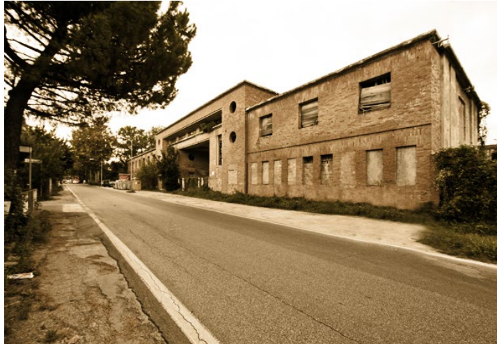
Fig.172 Vista edificio portale da via Marconi
