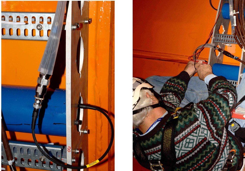
Figura 6.5: A sinistra: connessione dell'unità con il cavo di tipo N usato per portare il segnale in USC. A destra: Controllo che non ci siano corto circuiti fra l'unità e la struttura.
