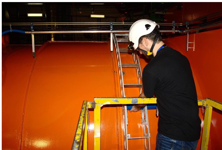
Figura 6.2: Installazione di una della unità di BHM.
