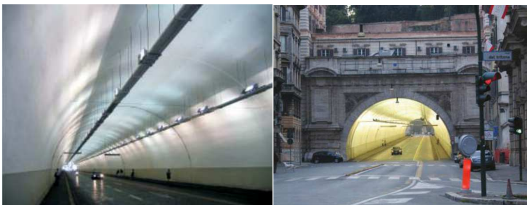
Figura 25 - La galleria Umberto I a Roma dopo il restauro [6], [38]
