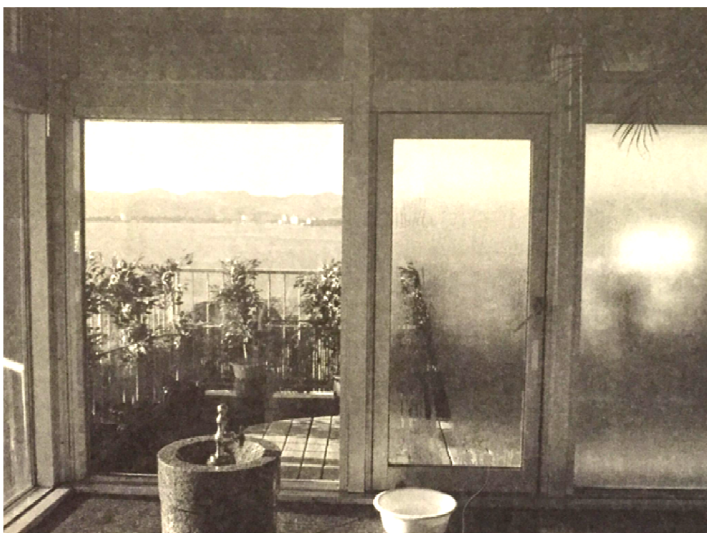
Figura 44 - Fenomeno di condensa assente su un vetro trattato con \text{TiO}_2 (a sinistra) e presente su uno non trattato (a destra) - [49]
