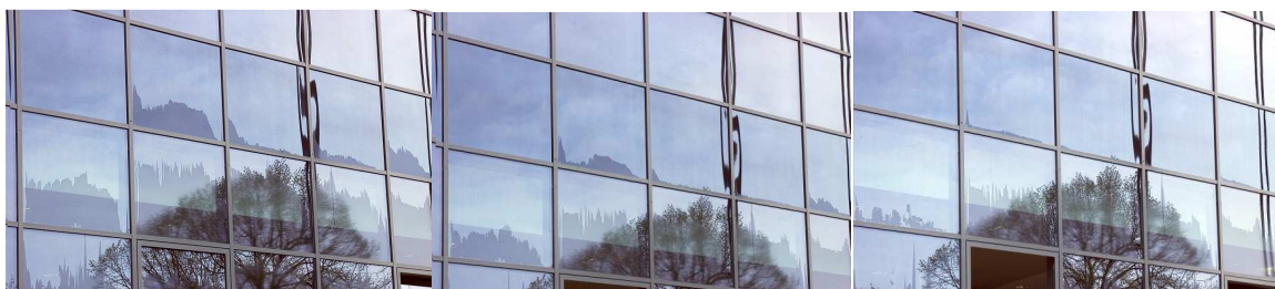
Figura 48 - Funzionamento del vetro autopulente Pilkington Activ TM: lo scorrimento dell'acqua non avviene "a gocce" ma per film sottile che rimuove le polveri e lo sporco organico decomposto senza lasciare tracce - [18]
