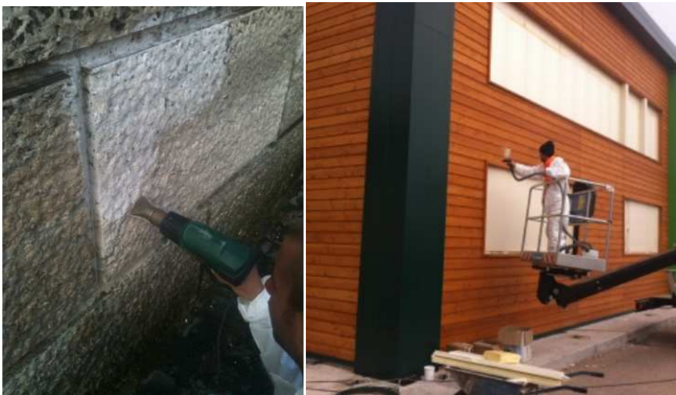
Figura 67 - Applicazione a spruzzo della sospensione \text{TiO}_2 nanotech su lastricato in travertino e su capannone industriale rivestito in materiale ligneo - [52]
