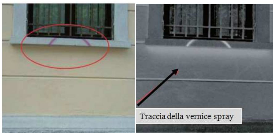
Figura 62 - Applicazione di pittura fotocatalitica agli uffici delle Ferrovie dello Stato di via Pietramellara a Bologna - La striscia lilla sul davanzale bianco è ciò che rimane di un atto vandalico: sulla vernice fotocatalitica non è rimasto che il vago ricordo del deturpamento (visibile solamente giocando con il contrasto e i colori della fotografia, sulla destra), mentre sul davanzale (verniciato con una normale vernice per esterni) è ancora ben visibile a occhio nudo la striscia colorata - [39]
