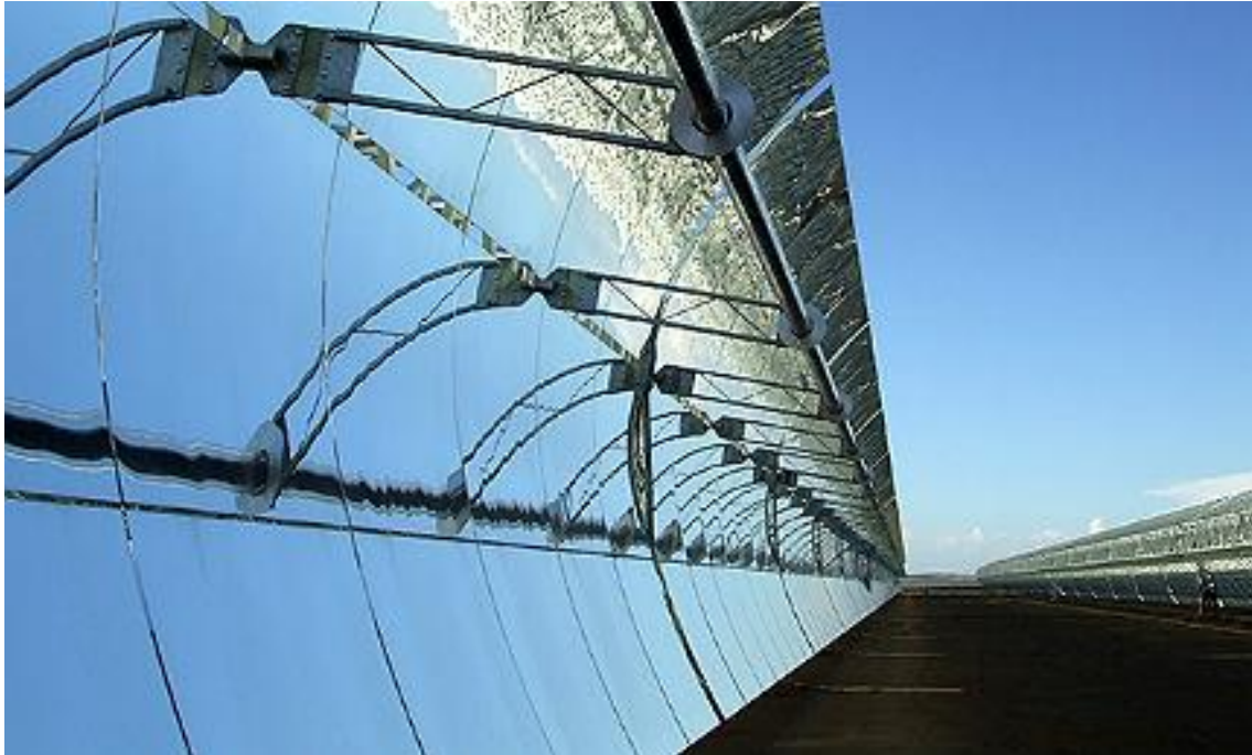
Figura 1.2 Impianto a specchi parabolici lineari Solana. Arizona.
