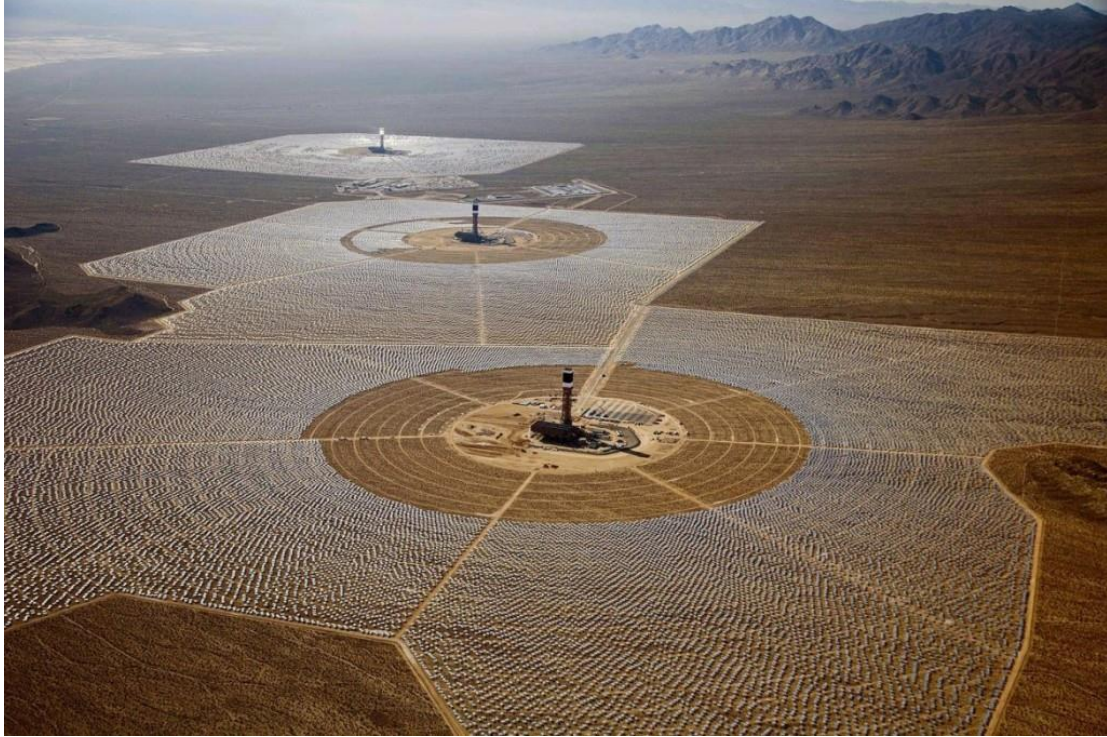
Figura 1.4 Impianto a torre di potenza Ivanpah. California.
