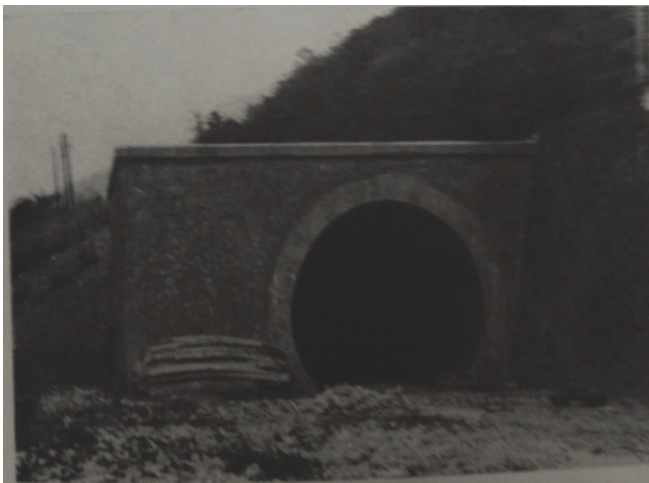
Fig. 11. - Galleria della Rovina: imbocco sud ricostruito.
