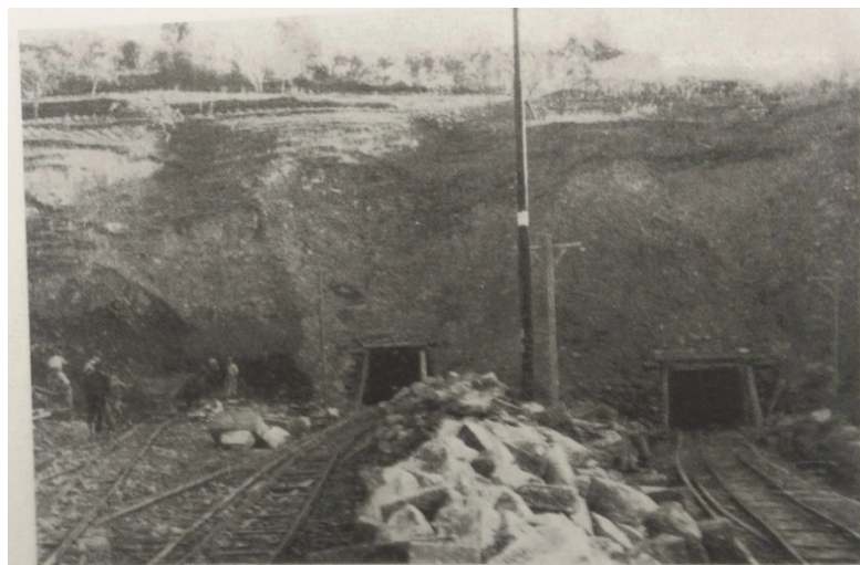
Fig. 17. - Galleria di corsa e di ricovero di Corbezzi. Inizio lavori.
