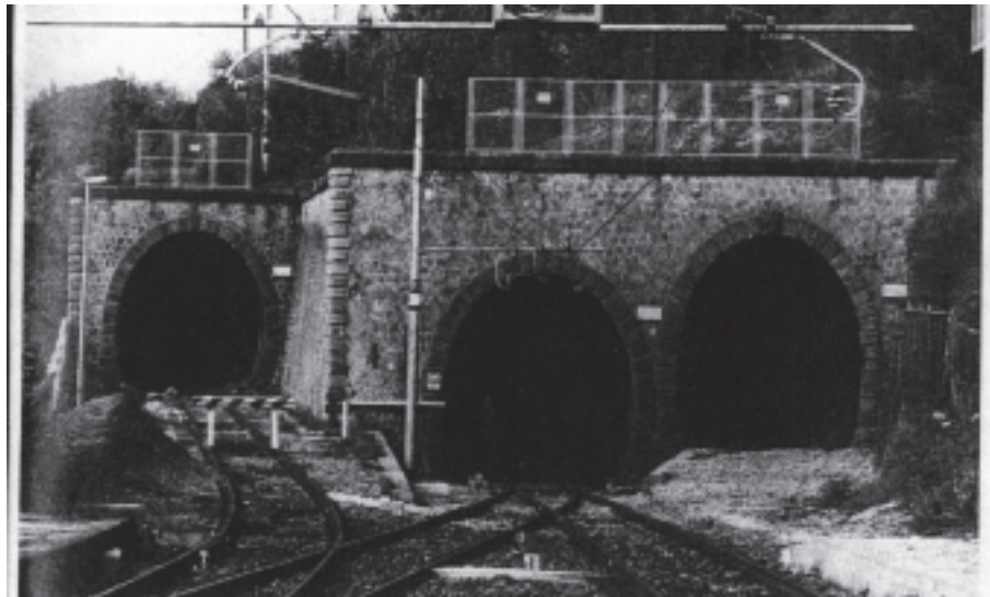
Galleria di Corbezzi: ai lati le gallerie dei binari di salvamento e sicurezza
