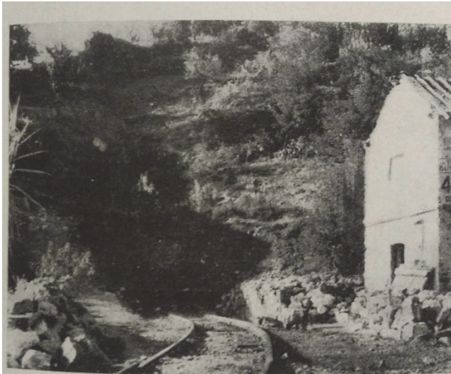
Fig. 20. - Galleria di Fabiana : imbocco nord prima di iniziare i lavori.
