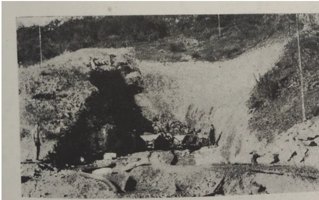
Fig. 6. - Galleria di Ponzano : imbocco sud : inizio lavori.
