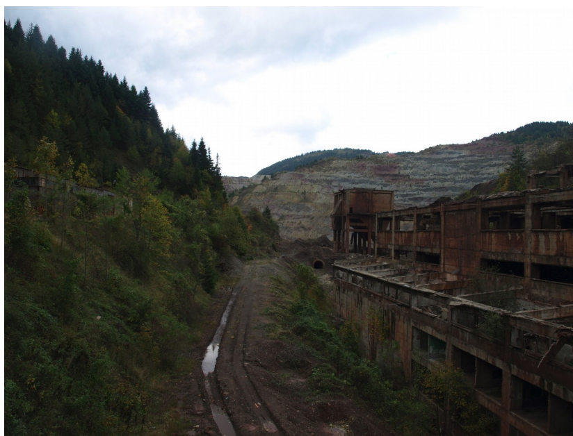
Figura 8: Foto della miniera abbandonata di Vareš, nello sfondo si vede la struttura a gradoni della miniera, mentre in primo piano è presente una parte della vecchia infrastruttura estrattiva.
