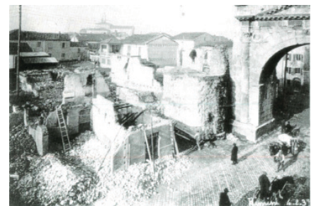
Fig. 11. Demolizioni degli edifici attigui all'arco di Augusto del '37.
