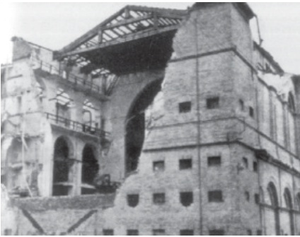
Fig. 17. Fotografia del teatro Vittorio Emanuele II, dopo i bombardamenti del settembre 1944.
