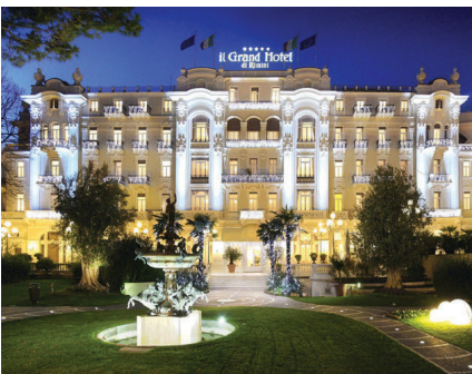
Fig. 17 Vista del Grand Hotel di Rimini; da www.bibliotecagambalunga.it
