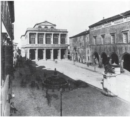
Fig. 9. Piazza Cavour foto anteriore al 1916.
