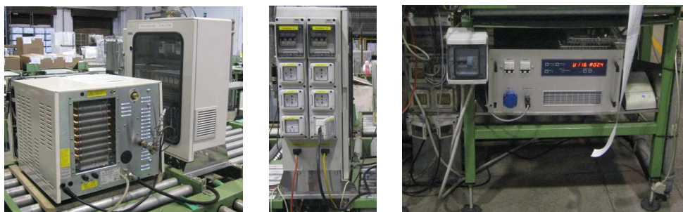
Figura 44 – Retro della postazione di collaudo, torre di collaudo e apparecchi che monitorano il corretto funzionamento dell'intero processo.
