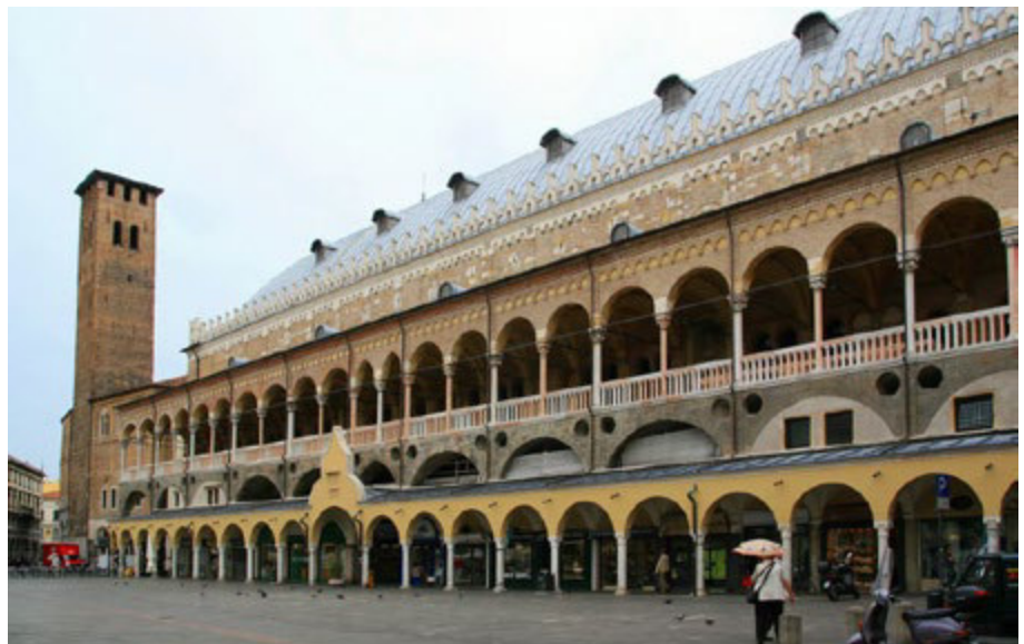
Uno dei fatti urbani presi in considerazione da Rossi ne "L'Architettura della città": Palazzo della Ragione, Padova.
