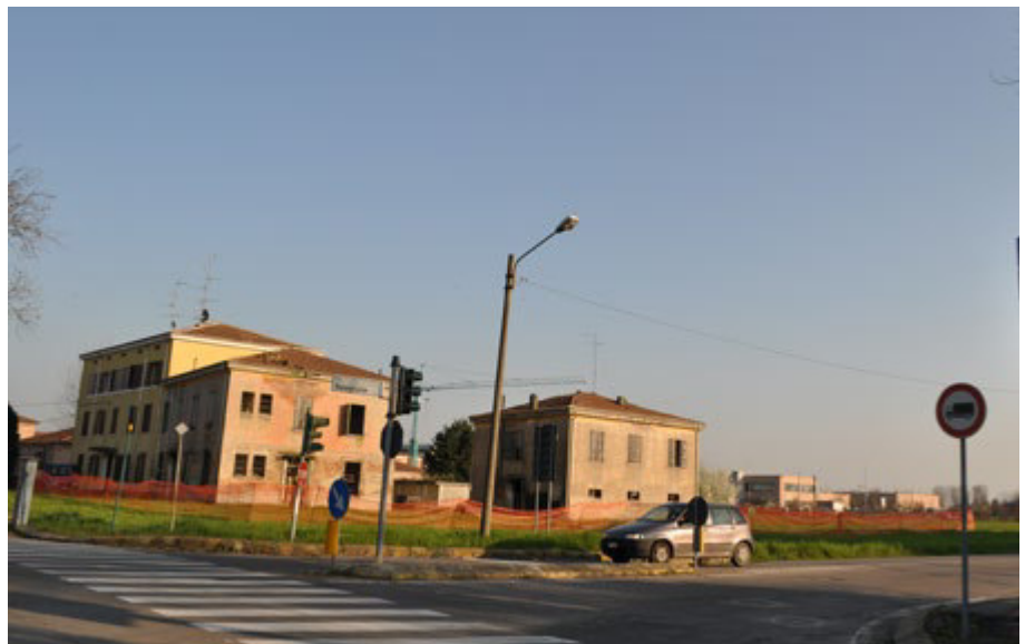
Via Gramsci, tessuto disgregato, foto da sopralluogo marzo 2014
