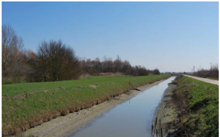
Canale di scolo delle acque
