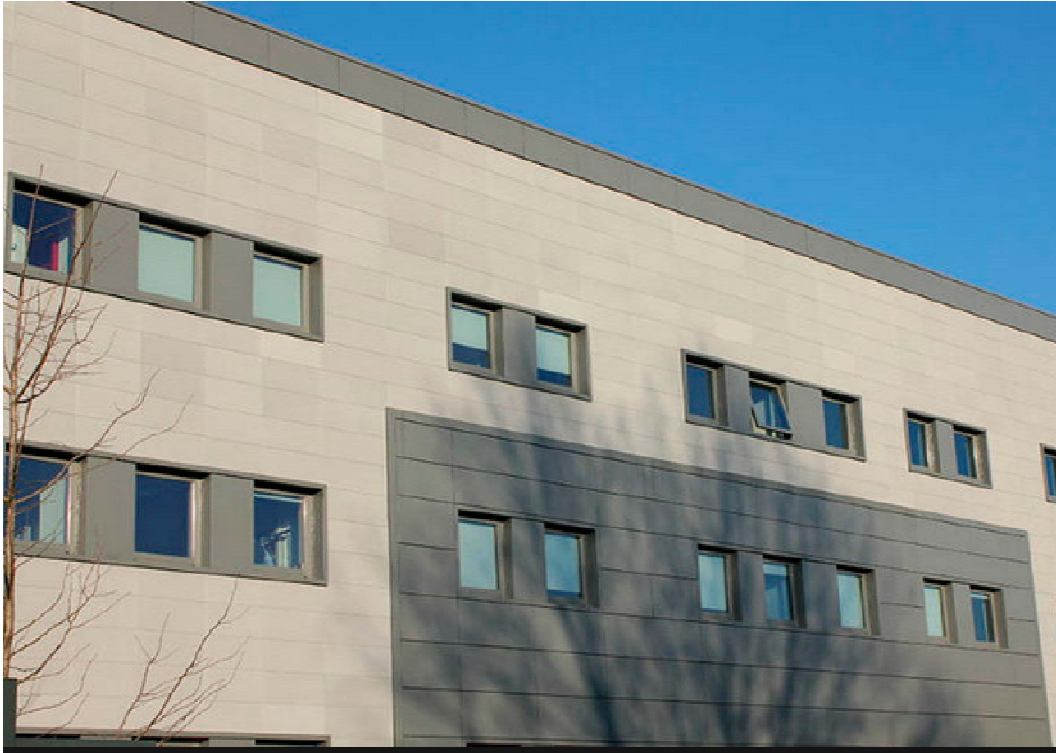
Figura 22 Rivestimento di facciata in fibrocemento / per facciate ventilate UFFICI MEDIASET PIZ srl (29)
