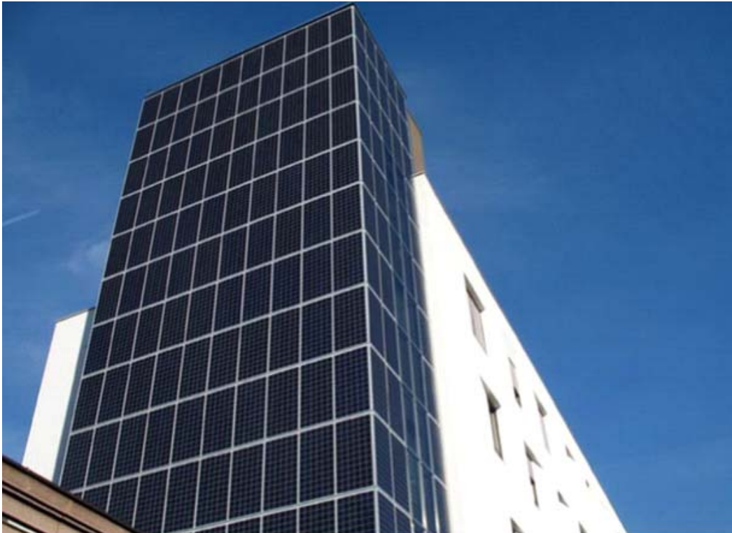
Figura 29 Modulo fotovoltaico integrato su facciata. (37)
