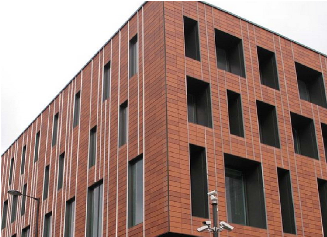
Figura 20 rivestimento in terra cotta (27)
