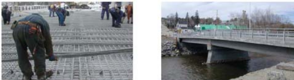
Figura 1.20 – Impalcato da ponte realizzato con GFRP, Cookshire, Eaton, Quebec
