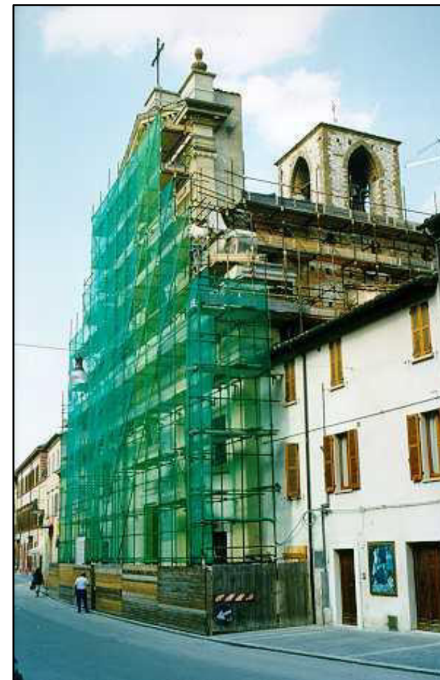
Cattedrale di Pergola, lavori per evitare il completo distacco della facciata, sisma 1997
