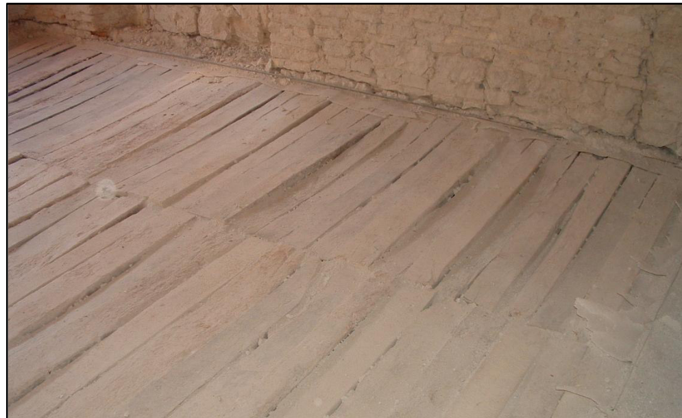
Estradosso di un solaio in legno ad una unica orditura in un edificio del centro storico di Pergola
