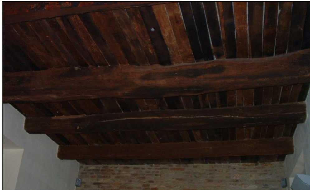
Intradosso di un solaio in legno ad una unica orditura in edificio del centro storico di Pergola
