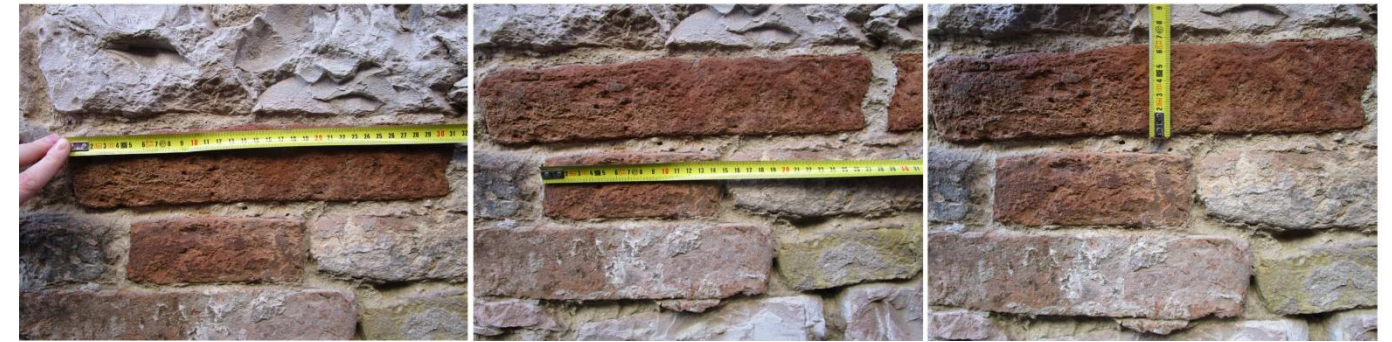
Misurazioni elementi in laterizio
