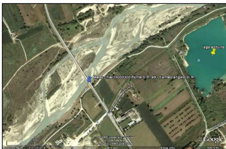
Figura 19 Ponte S:P:49 Santarcangelo di R.
