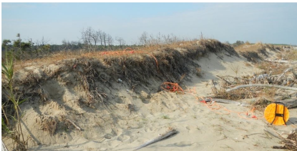
Figura 13. Avanduna con segni di scalzamento al piede
