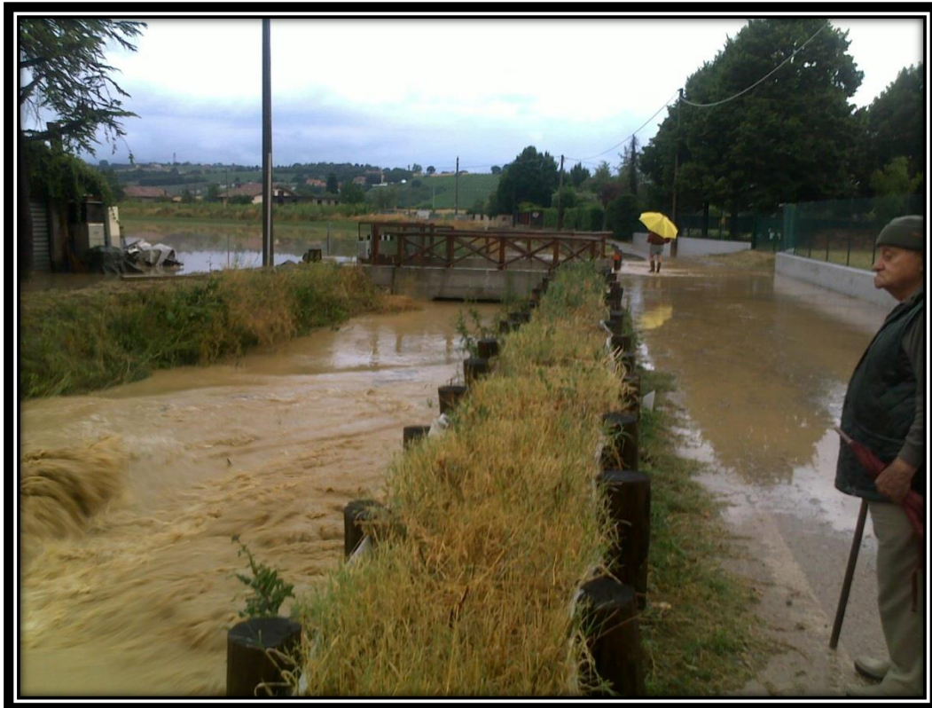
Figura 27 - Canale Calastra a seguito dell'evento estremo del 24/06/13
