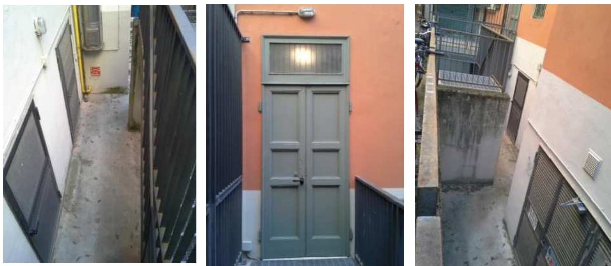
Figura 14: Opere per il trasferimento della centrale termica
