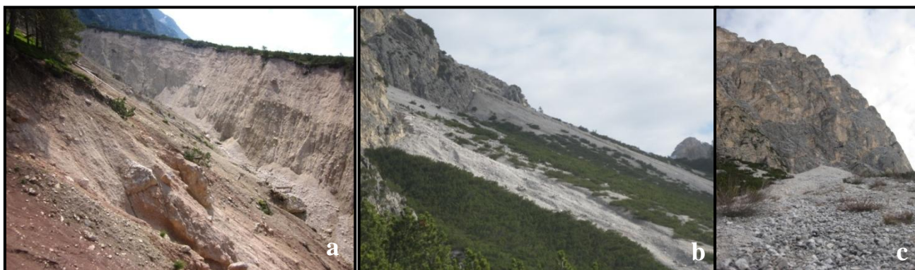
Fig. 17: tratto iniziale dell'area di scorrimento. a) canale fortemente inciso, b) canale mediamente inciso, c) colata non canalizzata.
