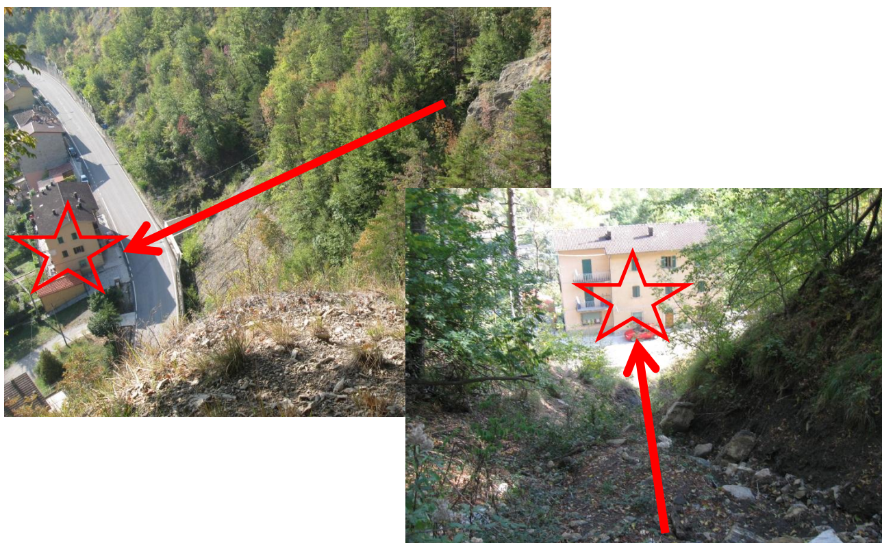
Figura 2 Il canale dove si verificò la prima colata detritica
