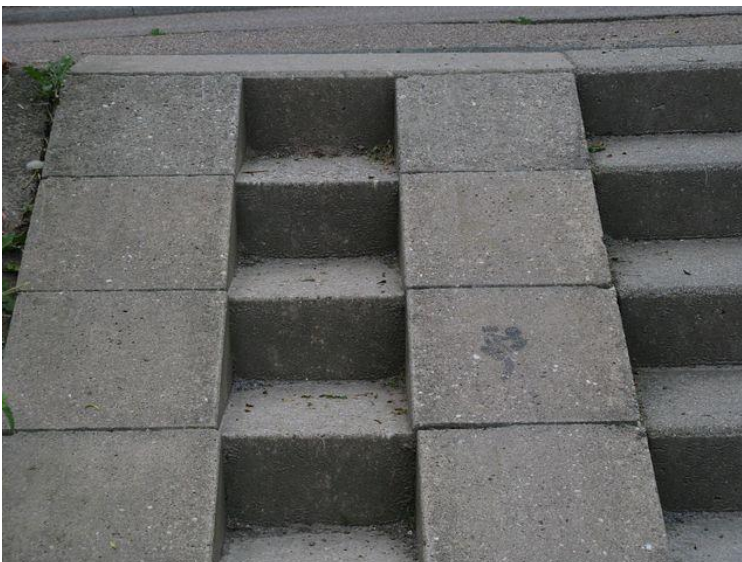
Figura 2.1.4 Rampe con forte pendenza
