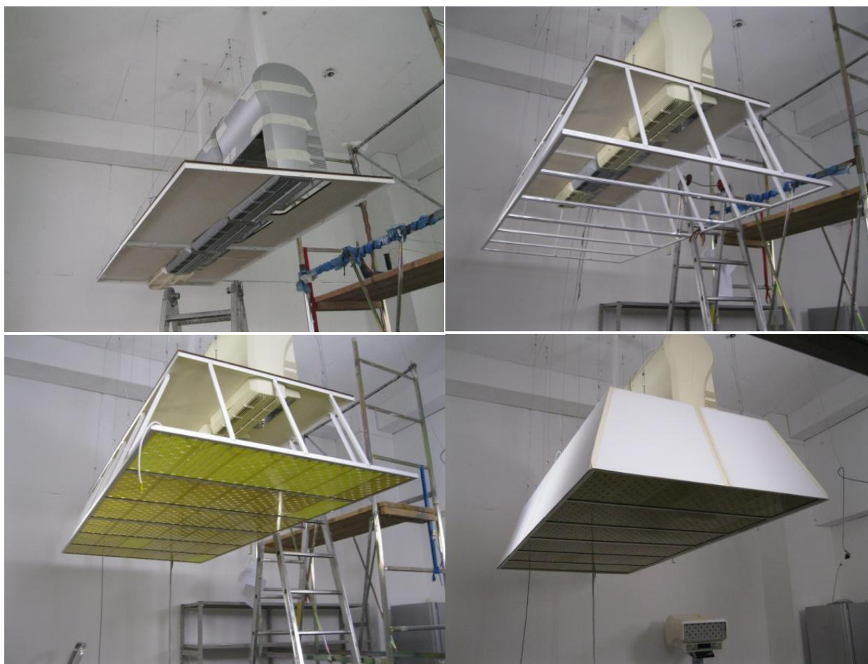
Figura 18 – Fasi di costruzione della cappa
