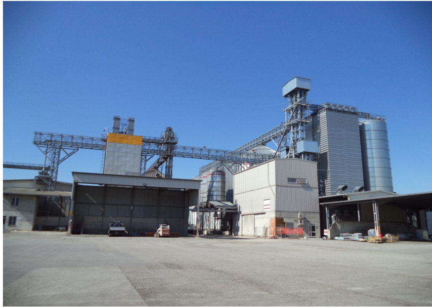
Figura 5: Piazzale e fosse di ricezione con tettoie dell' impianto di Capa Cologna
