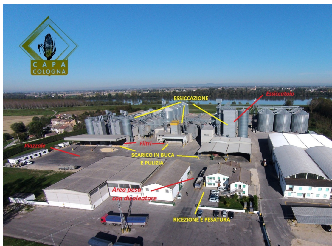
Figura 6: L'impianto di Capa Cologna: aree in cui avvengono i vari processi di trattamento del grano e del mais
