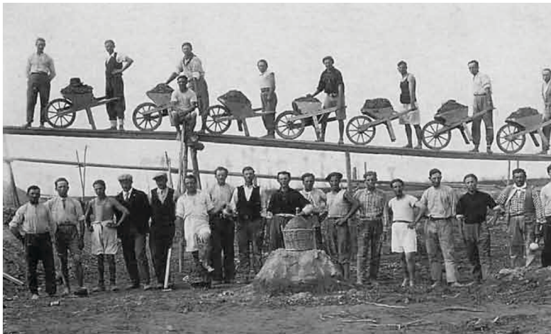
Fig. 3: Le lunghe file degli scariolanti intenti al duro lavoro di escavazione manuale delle canalizzazioni nella fase del prosciugamento.
