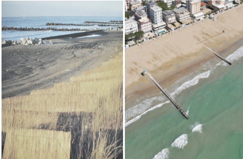
Fig.25-26: Serie di graticciate alla base delle dune con la funzione di ostacolare la rimozione della sabbia ad opera del vento nel periodo invernale. Sequenza di "pennelli" frangiflutti e barriere protettive lungo la spiaggia di Jesolo.
