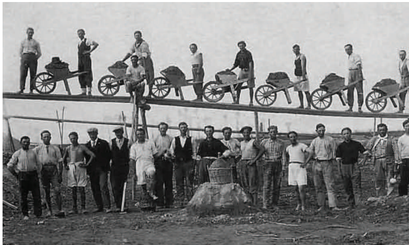
Fig. 3: Le lunghe file degli scariolanti intenti al duro lavoro di escavazione manuale delle canalizzazioni nella fase del prosciugamento.
