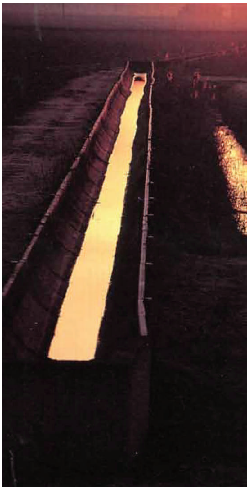
Fig. 8: La scolina e la canaletta irrigua: infrastrutture idrauliche minori della bonifica.
