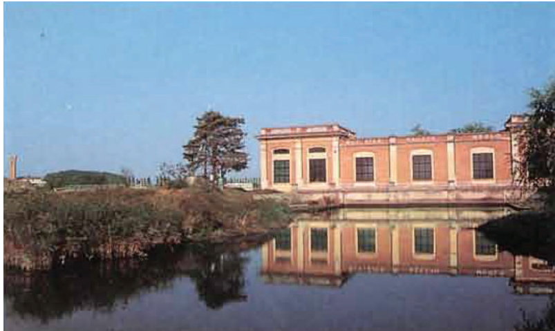
Fig. 6: L'idrovora di Portesine sulla sponda sinistra del Sile.
