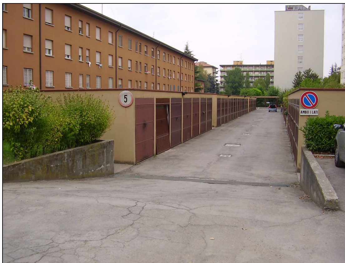
Fig. 4.41 – Panoramica su via Martiri di Piazza Fontana
