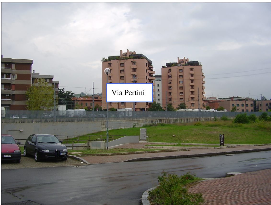
Fig. 4.66 – Segnale di nome-strada non presente all'incrocio
