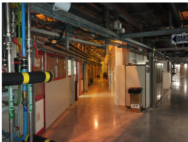
Figura 2.2.1: Immagine del corridoio della BM08
