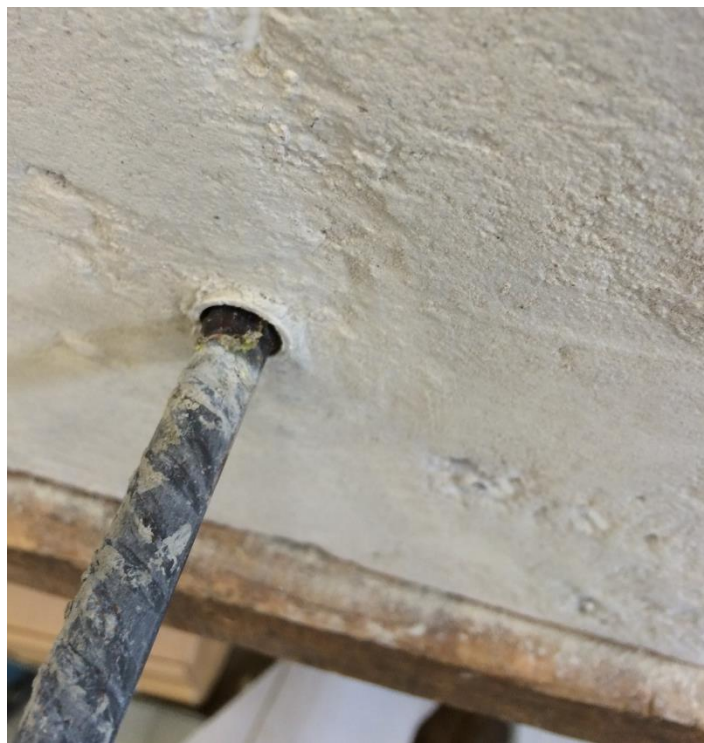
Figura 84. Dettaglio scorrimento barra-calcestruzzo lato inferiore prova P3C1BAN10 – 18/09/14
