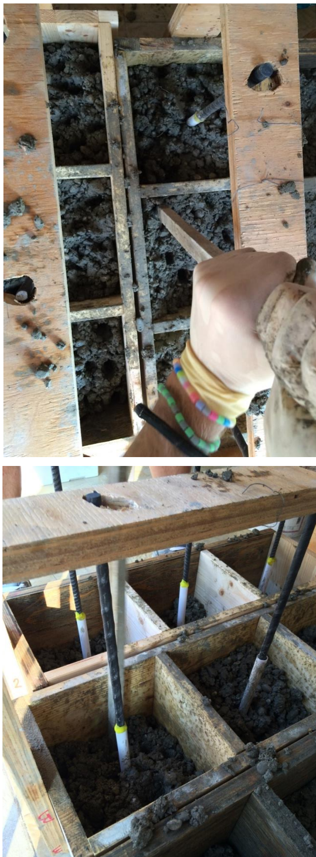
Figura 60. 3° Confezionamento – barre lisce \Phi 10 CLS2
