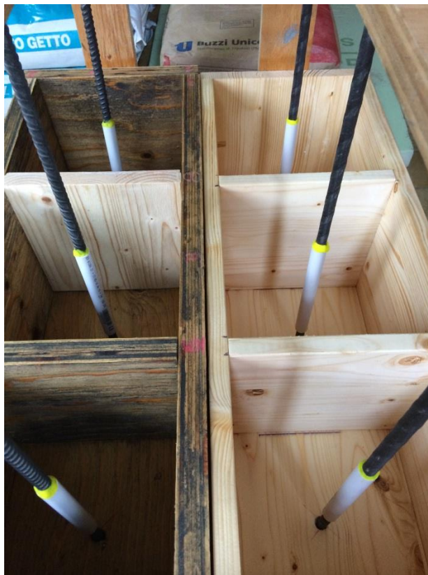
Figura 52. Casseforme in legno e posizionamento delle barre
