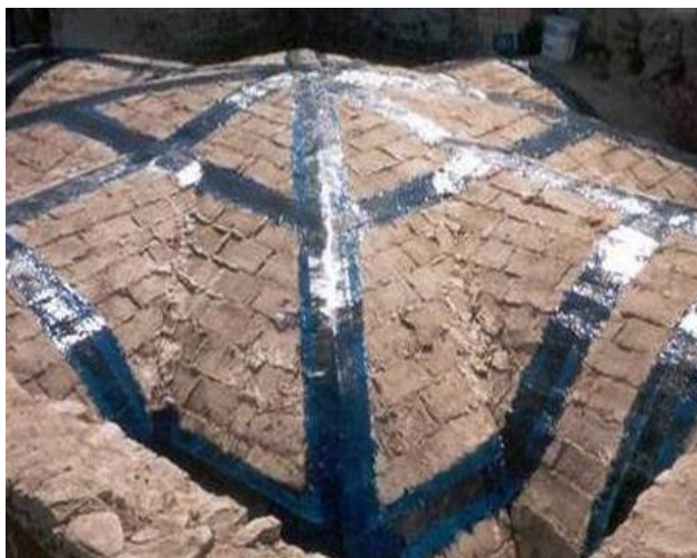
Figura 20. Rinforzo volta a crociera con tessuto CFRP
