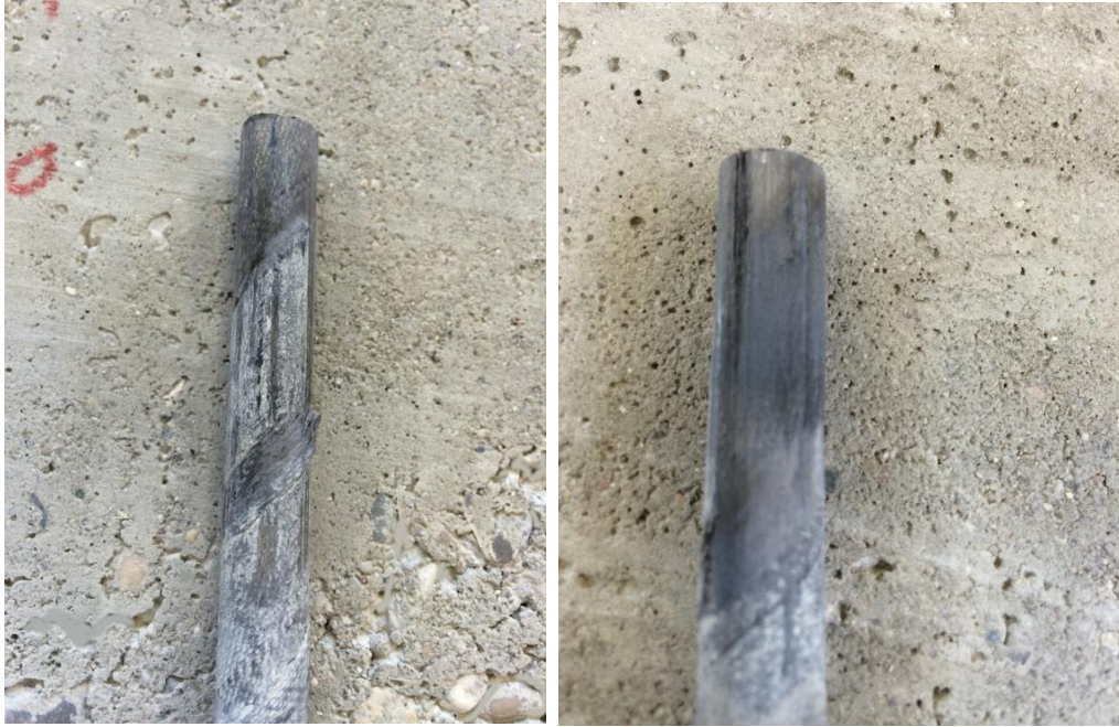
Figura 89. Dettaglio della barra estratta: distacco del filamento in fibra di carbonio che avvolgeva la barra - prova P4C1BCN10 – 18/09/14
