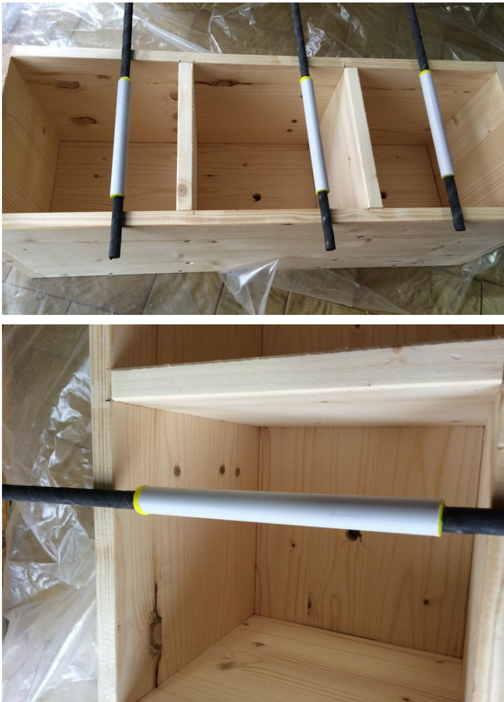
Figura 54. Isolamento della parte superiore della barra con tubo in PVC
