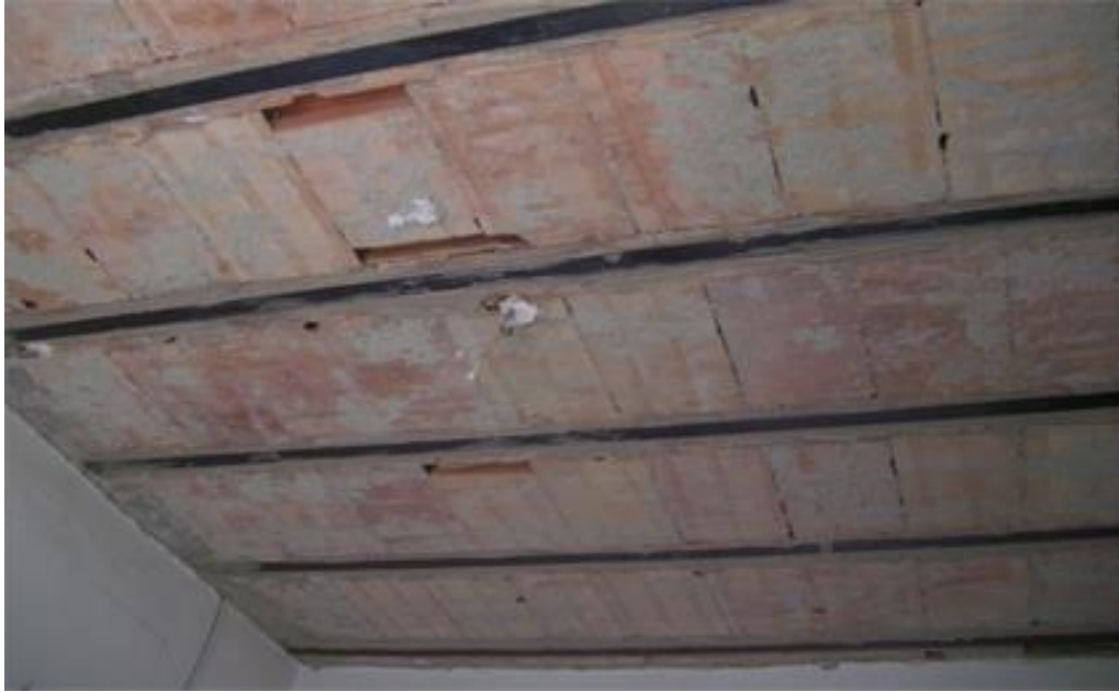
Figura 21. Rinforzo a flessione di travetti di solaio con lamine in CFRP
