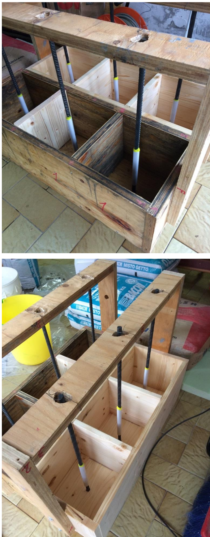
Figura 53. Casseforme in legno e posizionamento delle barre
