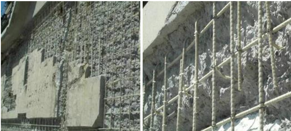
Figura 24. Sostituzione armatura d'acciaio con griglia di barre GFRP in una struttura marina
