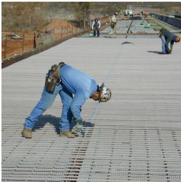
Figura 25. Solette da ponte con armatura in GFRP
