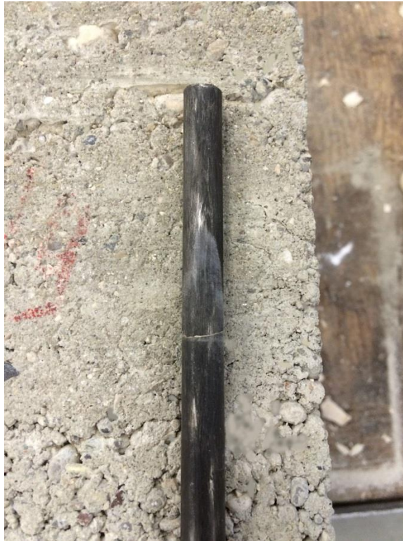
Figura 94. Dettaglio della barra estratta prova P5C1BAL10 – 19/09/14
