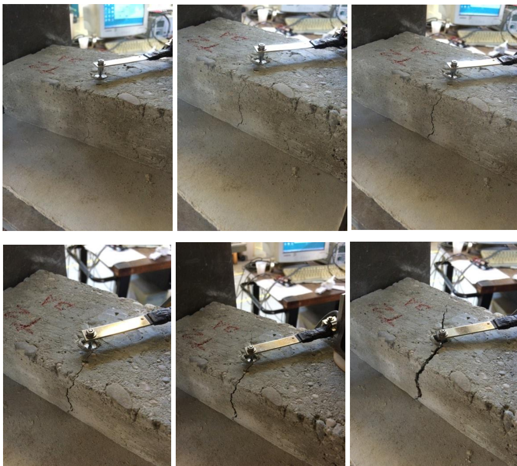
Figura 107. Propagazione della fessurazione da Splitting Prova P9C1BAN10S – 22/09/14
