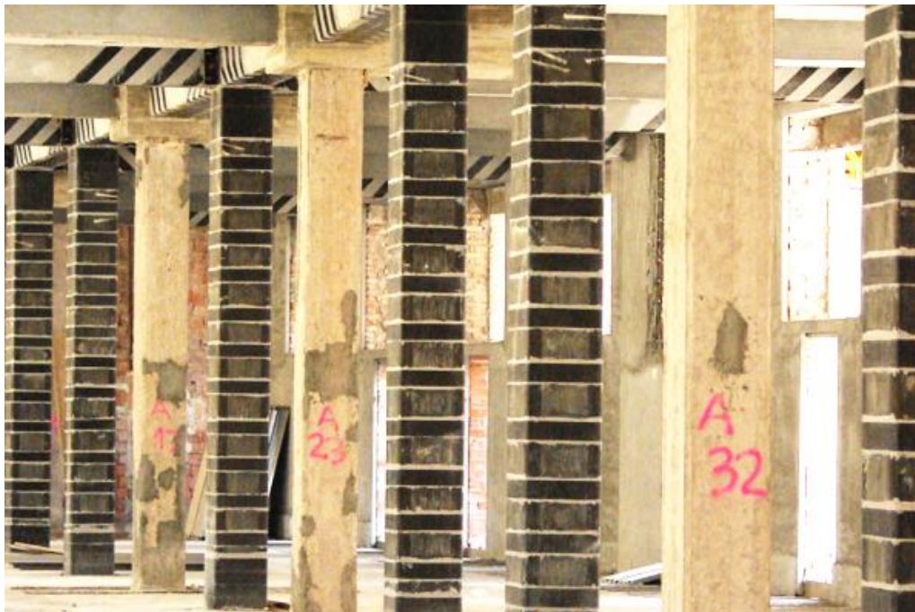
Figura 22. Confinamento pilastri con tessuto in CFRP
