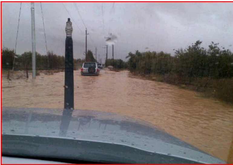
Figura 4.29 Situazione di allagamento in corrispondenza del viale d'ingresso al campo
