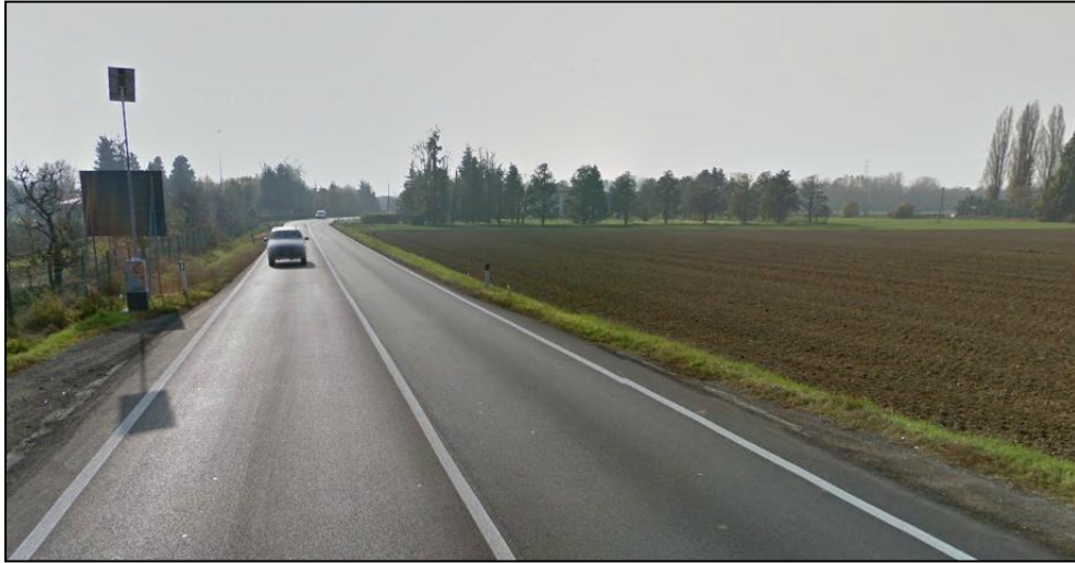
Figura 2.3: SP 26 “Valle del Lavino”, Postazione 502 (km 0+730)
