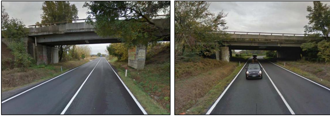
Figura A.4: Tratto I - Viadotti non protetti
