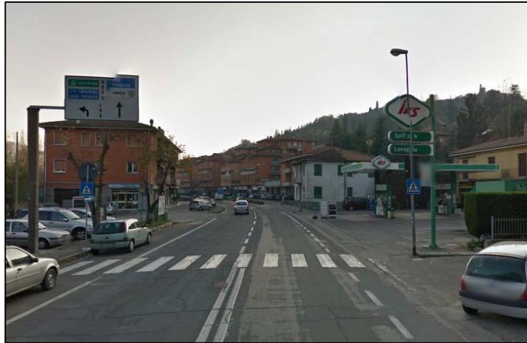
Figura A.50: Tratto XII - Attraversamento al km 8+800
