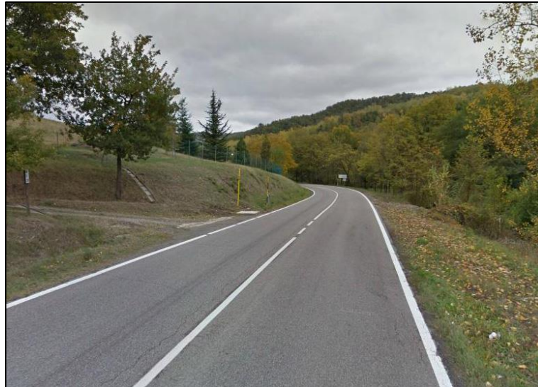
Figura A.70: Tratto XVI - Accesso con visibilità ridotta
