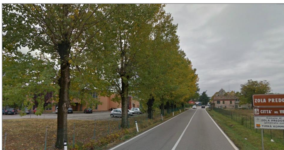
Figura A.11: Tratto II - Alberatura pericolosa
