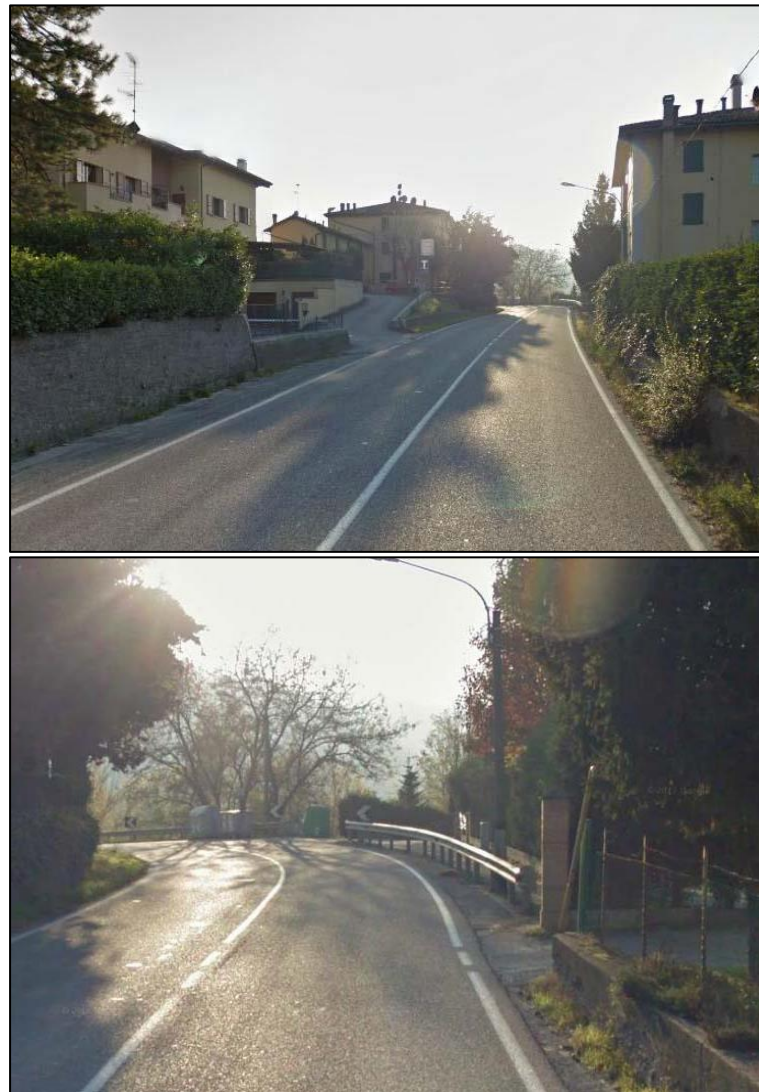
Figura A.43: Tratto X - Accessi pericolosi
