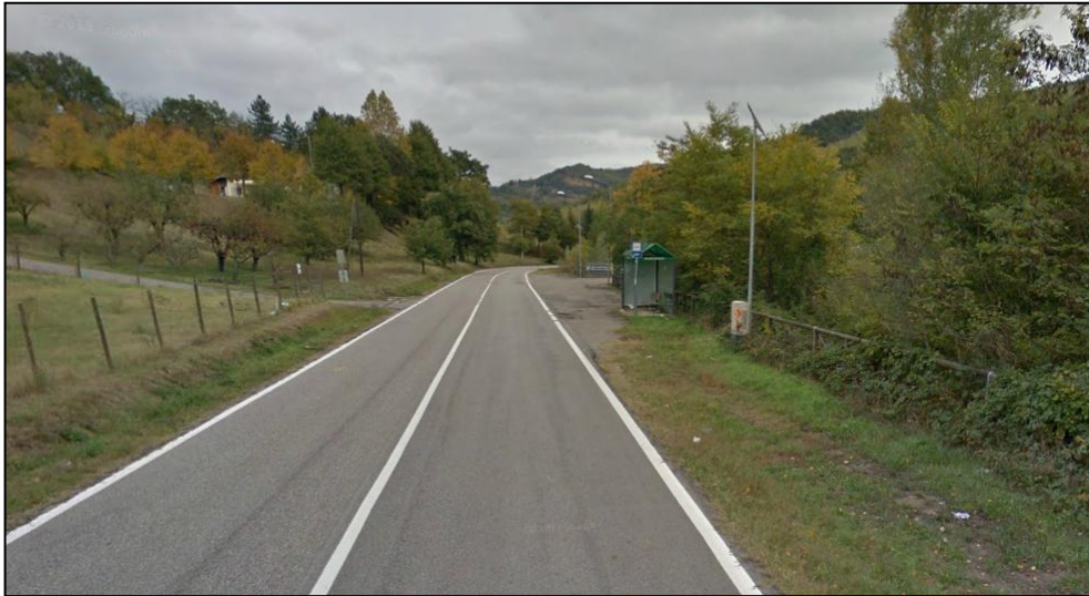
Figura 2.5: SP 26 “Valle del Lavino”, postazione 503 (km 16+560)
