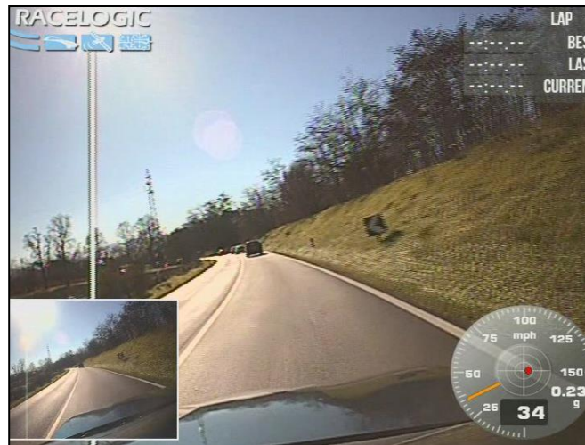
Figura A.5: Tratto I - assenza di fosso di guardia
