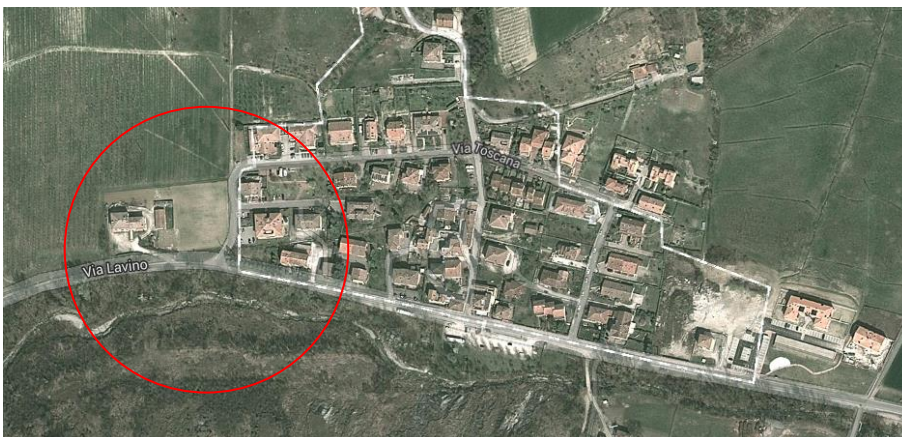
Figura 6.60: Ambiente in ingresso Oca direzione Bologna
