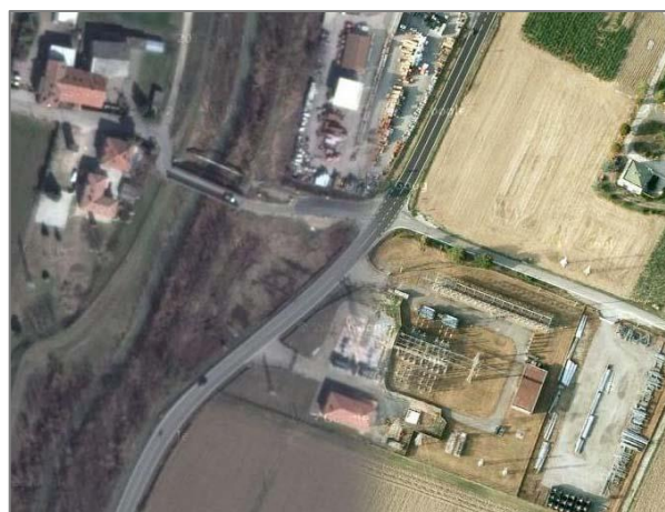
Figura A.8: Tratto I - Intersezione pericolosa
