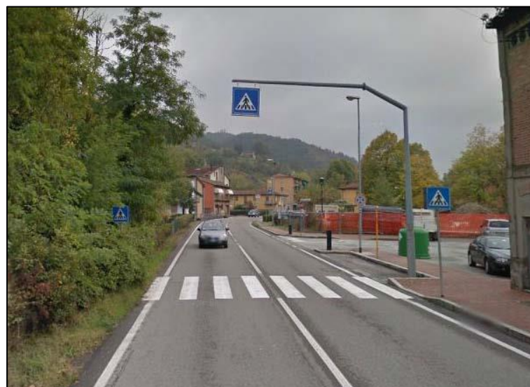
Figura A.49: Tratto XII - Attraversamento al km 9+300
