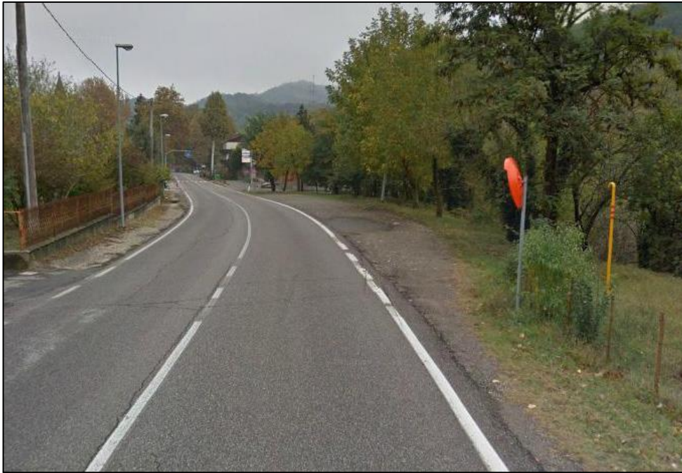
Figura A.65: Tratto XV - Area lato carreggiata
