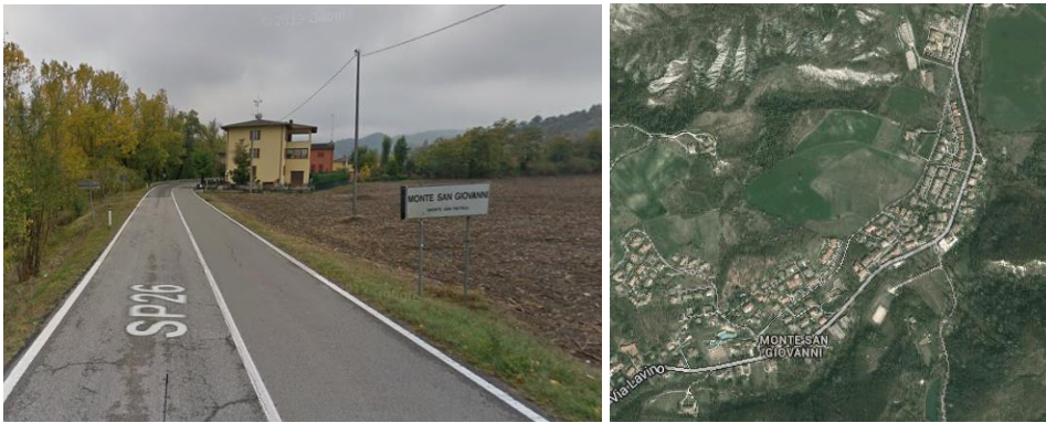
Figura 6.56: Ambiente in ingresso Monte San Giovanni direzione Vergato
