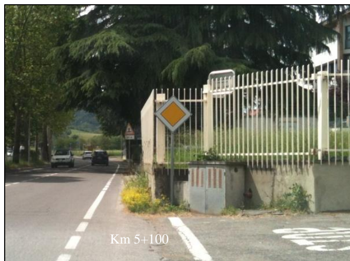
Figura 3.8: Segnaletica verticale poco visibile
