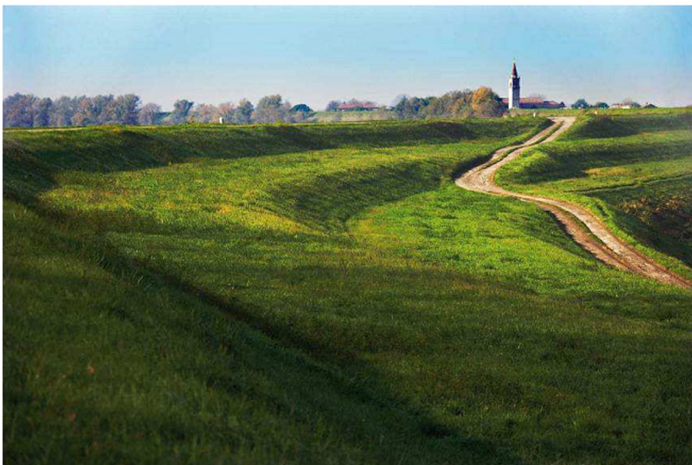
Figura 1 – Vista di un tratto di argine maestro del fiume Po
