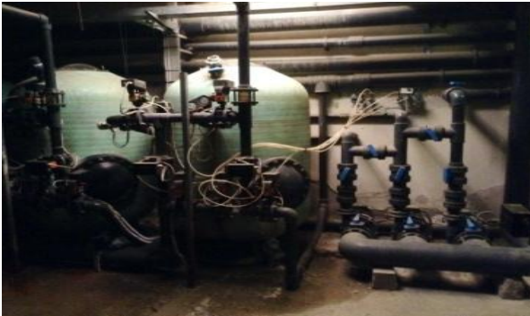
Figura 8.6 – Il doppio filtro meccanico della V5 e le tre pompe (Foto di Giovanni Rossi, 2014).
