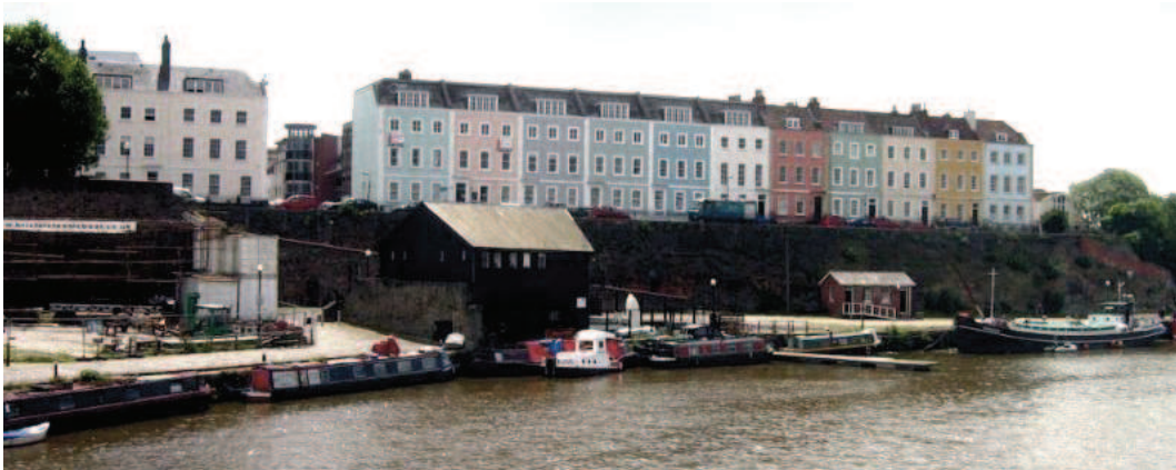
Redcliffe Parade vista dalla banchina
