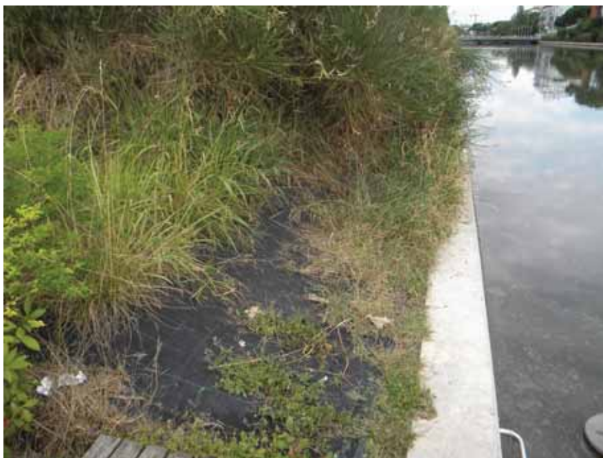
Figura 202 - Dettaglio protezione superficiale della terra rinforzata
