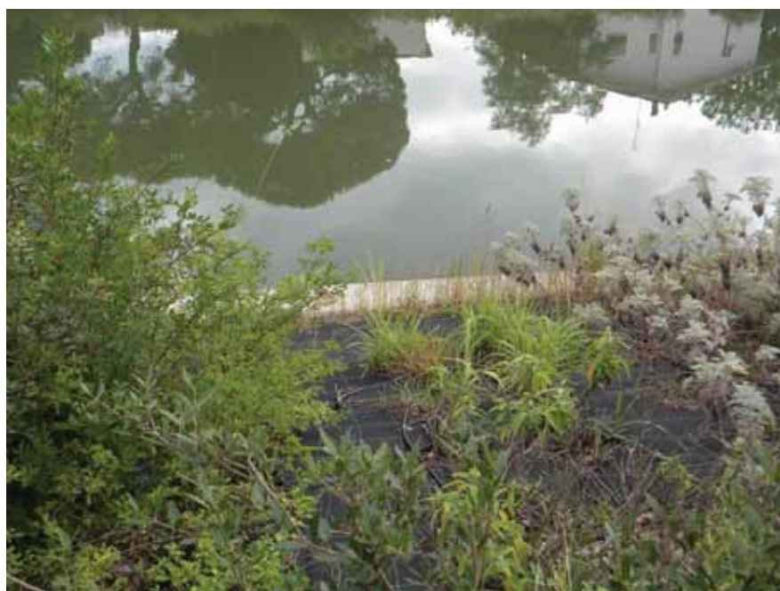
Figura 203 - Dettaglio rinverdimento e protezione della sponda
