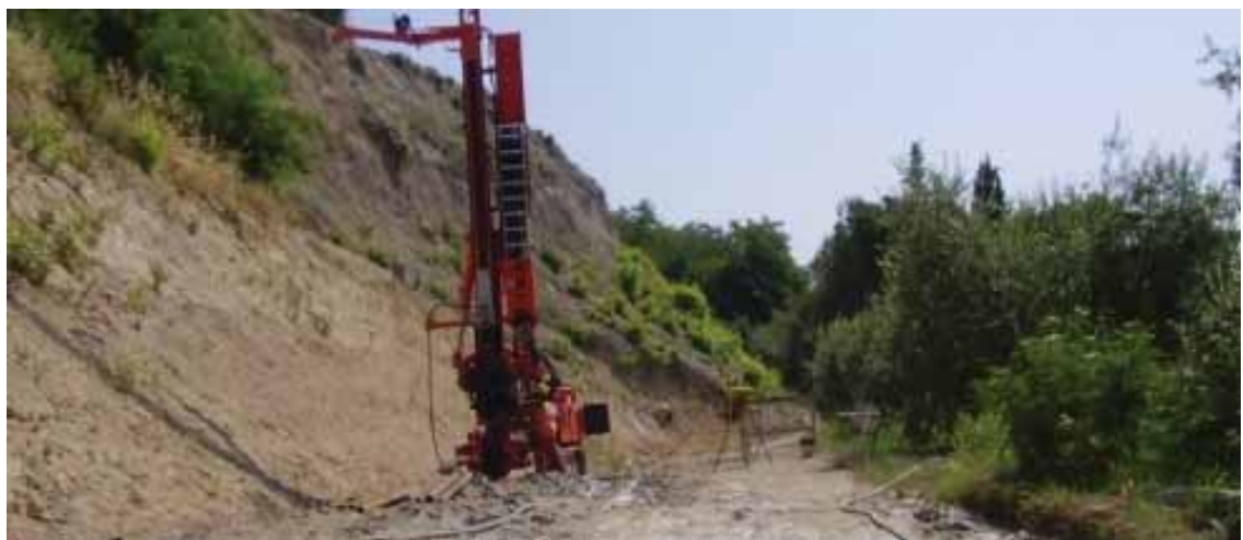
Figura 201 - Dettaglio Consolidamento al piede di un pendio
