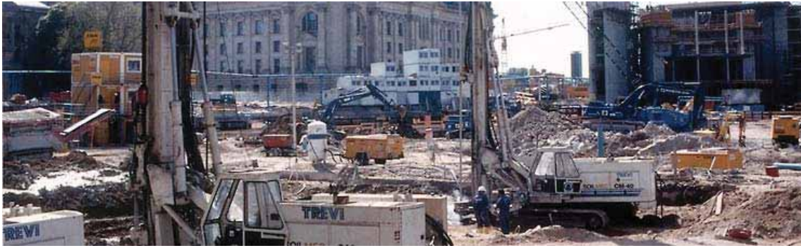
Figura 199 - Panoramica dell'attrezzatura di perforazione
