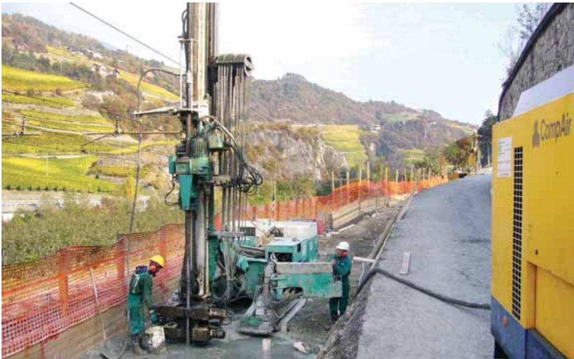
Figura 200 - Dettaglio macchinari mobili
