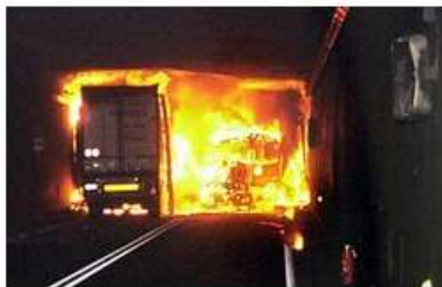
Figura 1.23: incendio del 24 ottobre 2001 nella galleria autostradale del San Gottardo.
