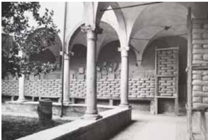
Fig. 9. Primo chiostro dell'ex monastero di San Vitale (anni '40 circa). Protezione antiaerea delle opere d'arte mobili. Dietro al sistema protettivo si vede il primo allestimento di Gerola.
