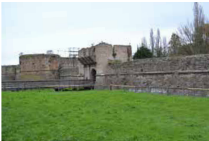
Fig. 2. Il fossato dell'antica Rocca, con il pontile d'accesso alla cittadella.
