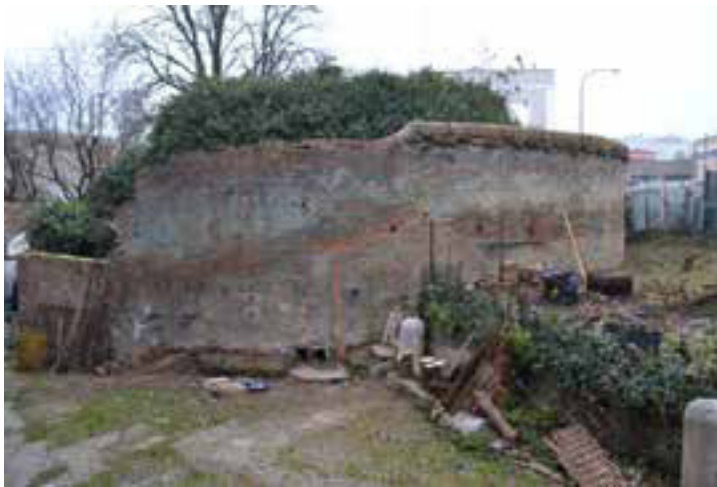
Fig. 21. Il muro che circonda il Torrione della Polveriera, visto da via Don Giovanni Minzoni.
