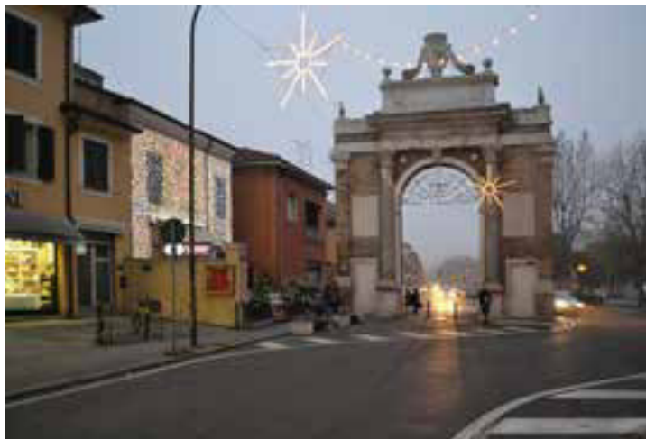
Fig. 12. Il fronte esterno di Porta Nuova vista dalla parte sud di via di Roma.
