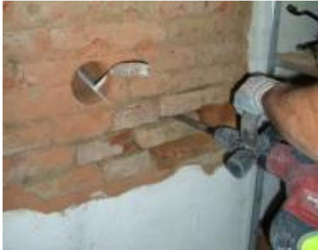
**Figura 36:** Estrazione di un elemento prismatico
