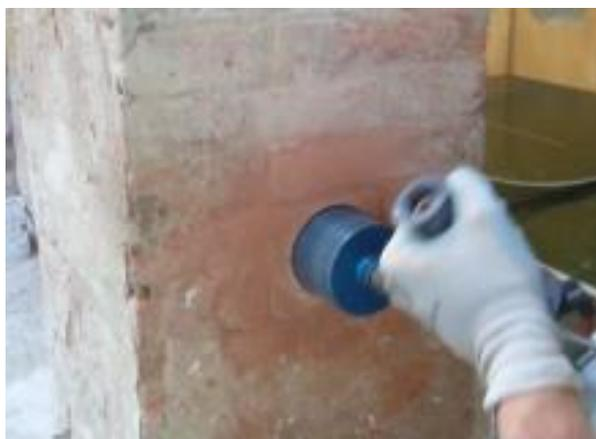
**Figura 35:** *Carotaggio su pilastro in muratura*
