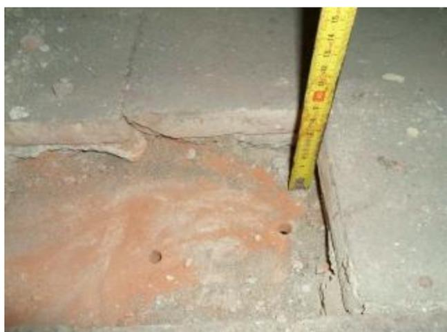
**Figura 48:** *Particolare del solaio con tavella*
