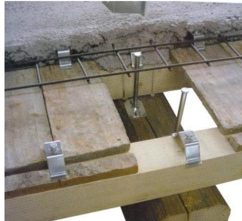
**Figura 103:** *Dettaglio del connettore e vista della messa in opera*
