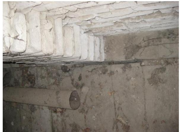
**Figura 90:** Posizione C distacco solai dalle pareti
