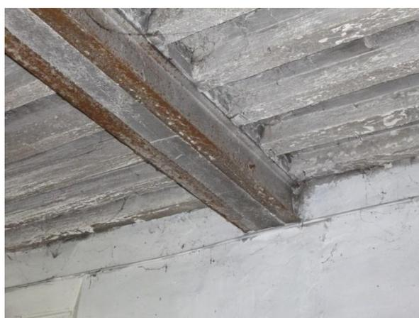
**Figura 47:** *Particolare solaio a doppia orditura*
