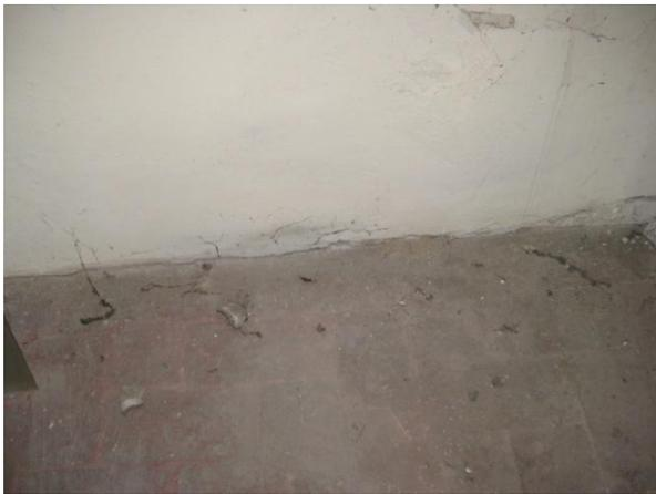
**Figura 89:** Posizione B, distacco solai dalle pareti
