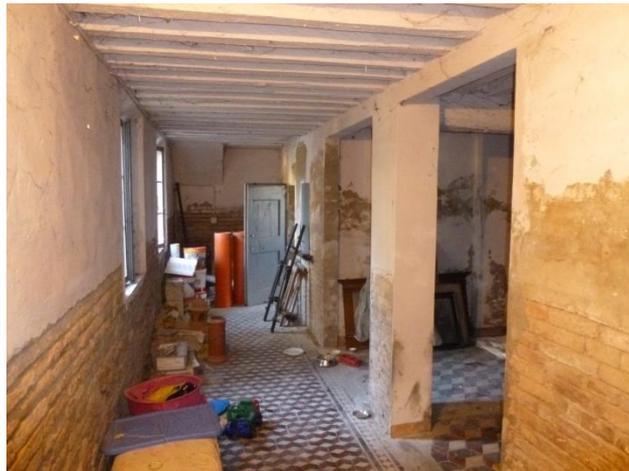
**Figura 49:** *Solaio a singola orditura*
