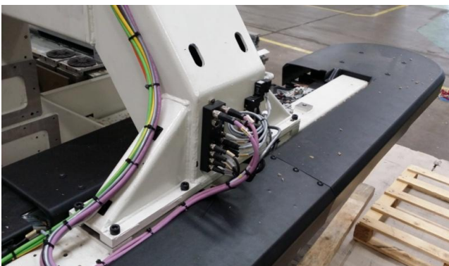
Fig. 3-17: dettaglio cablaggi pneumatici ed elettrici del magazzino
