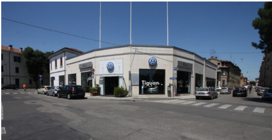
2.18_edificio della concessionaria
