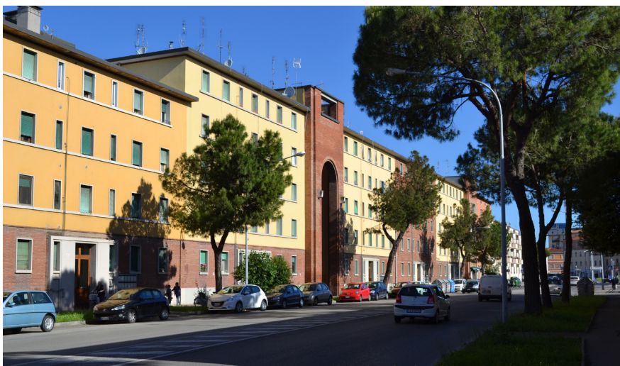
3.6_vista generale dell'edificio
