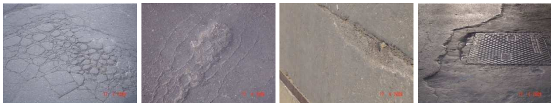
Figura 47: dettagli della pavimentazione esterna
