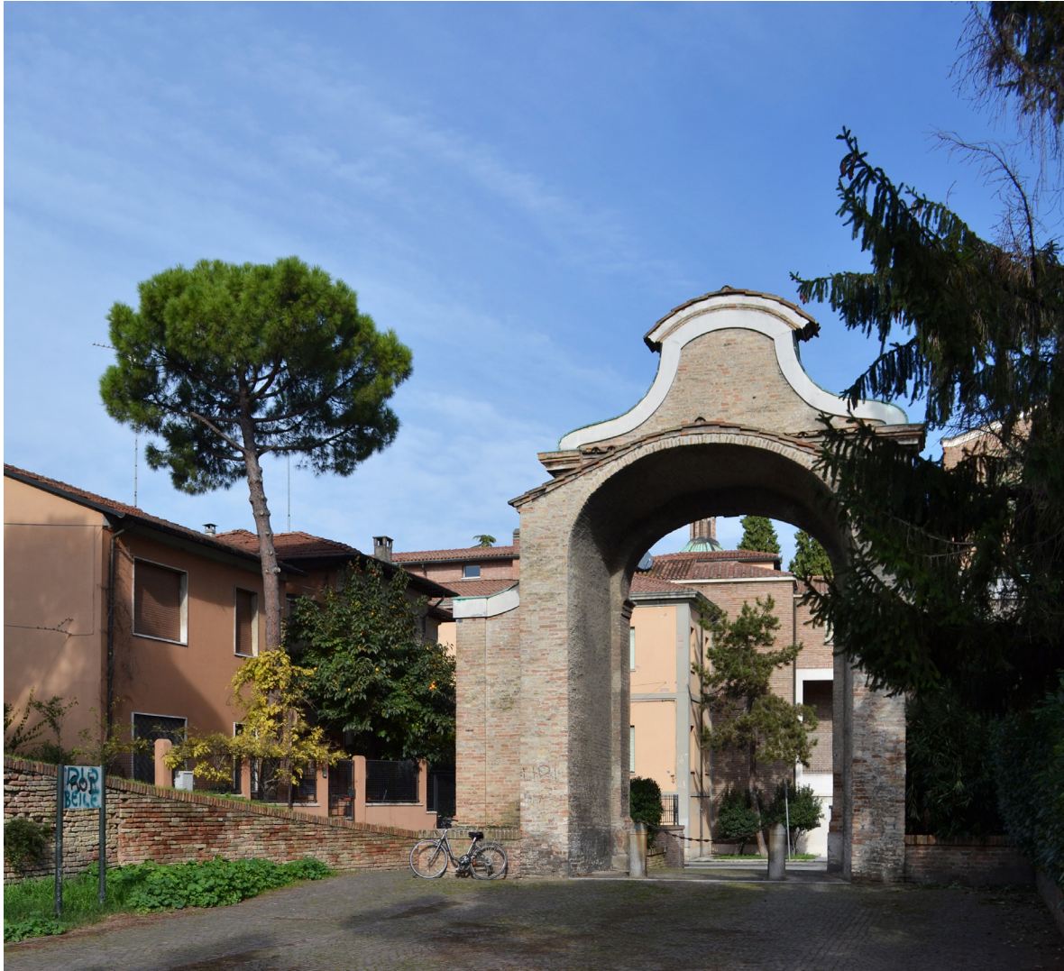
Fig 2.5 lato esterno di Porta Gaza visto da via Mura di Porta Gaza.
