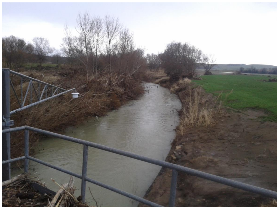
Fig. 2.16 Vista verso valle del fiume Fiora in corrispondenza dell'idrografo di Vulci. Dalle foto si notano le tracce dell'esondazione e la posizione dello strumento di misura, ruotato dal passaggio dell'onda rispetto alla posizione originale.
