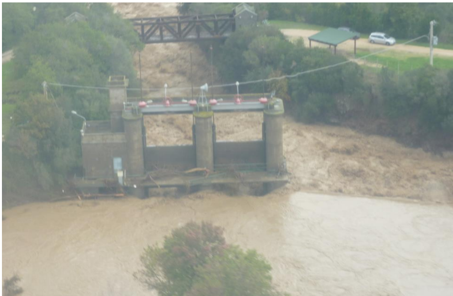
Fig. 2.10 Fotografie dell'evento di piena del 12 novembre 2013 che evidenziano la mutua interazione idraulica dello scarico di superficie e di quello di alleggerimento. Foto A - ore 06:15; Foto B – ore 11:30.
