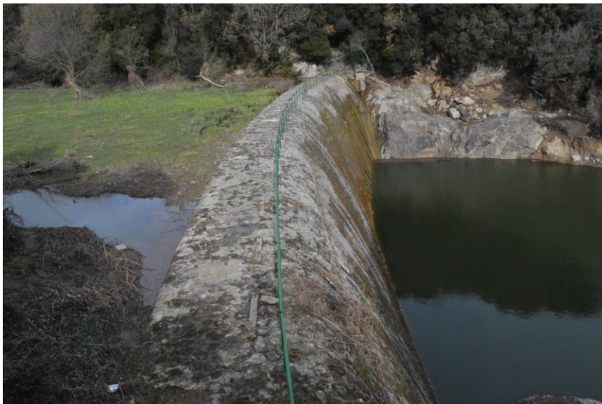
Fig. 2.4 Vista laterale della diga “vecchia” di Vulci
