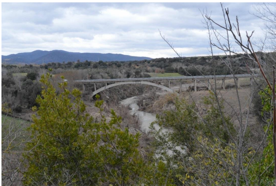
Fig. 3.11 – Foto del ponte statale SP107 (la sua schematizzazione in Hec-Ras è stata cautelativamente implementata ipotizzando un completo intasamento del telaio portante, ad opera del materiale flottante trasportato in occasione della piena).
