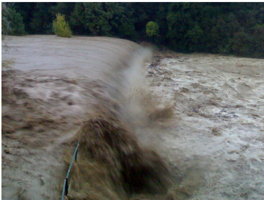
Fig. 2.22-2.23 Evento di piena del 12 novembre 2013, fotografie del ciglio tracimante della diga. Foto sopra – 12 novembre ore 07:15; Foto sotto – 13 novembre ore 11:30.
