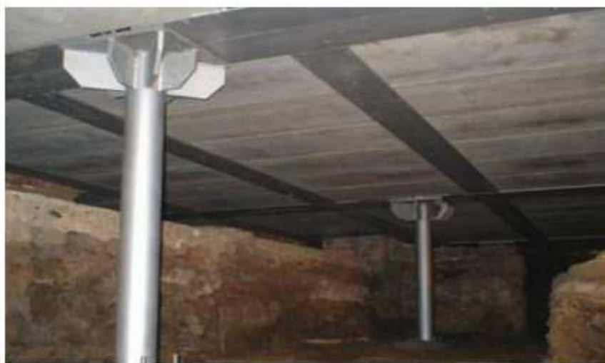
Figura. 1.3 - Trave con piastra in acciaio realizzata in opera
