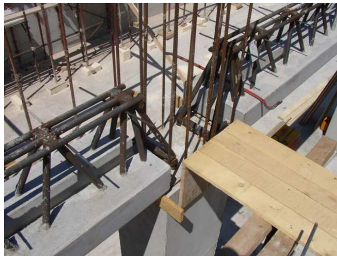
Figura 1.5 - Realizzazione trave con fondello in cls
