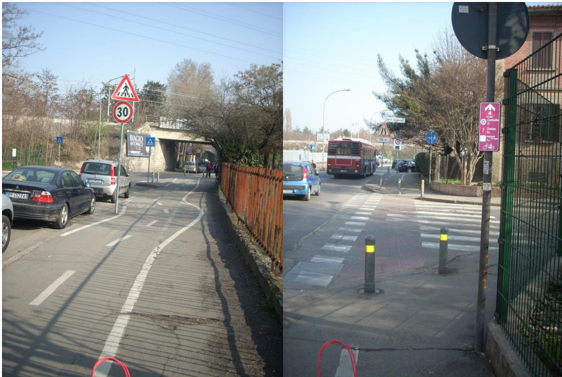
Immagine percorso ciclopedonale Via dell'Arcoveggio
