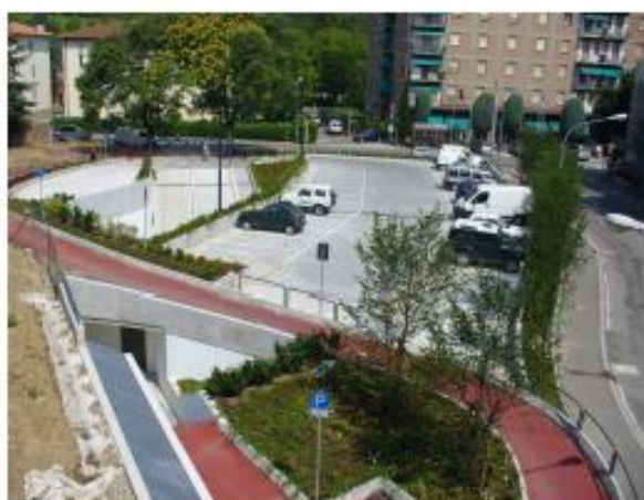
Parcheggio alla stazione di Rastignano
