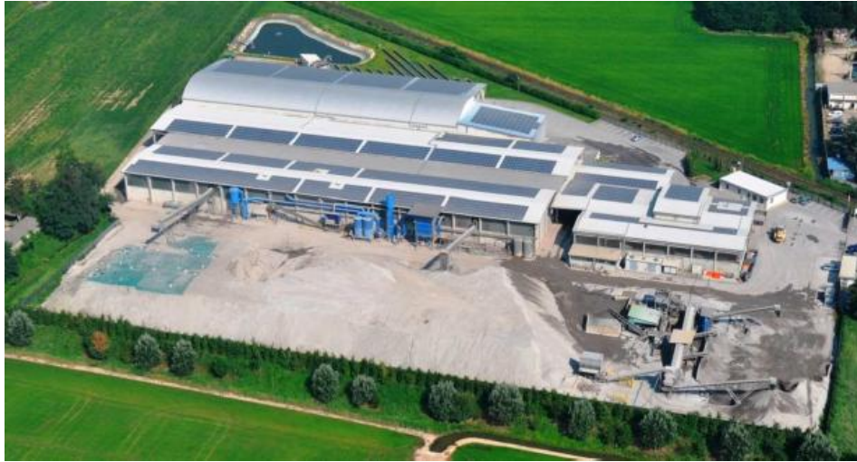
Figure 1.7 Overview of the Officina dell'Ambiente plant ( Officina dell'Ambiente , Environmental Declaration 2012)
