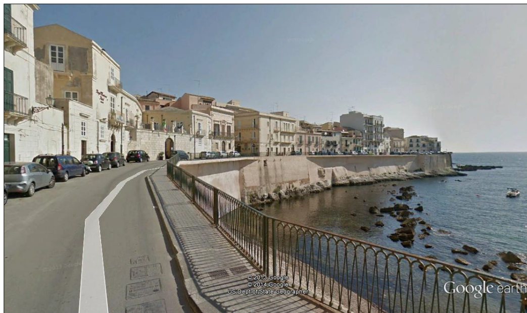
Figura 31: Esempio di edifici selezionati per la loro posizione particolare nonostante la loro elevazione fosse al di sopra dei 5 m.
