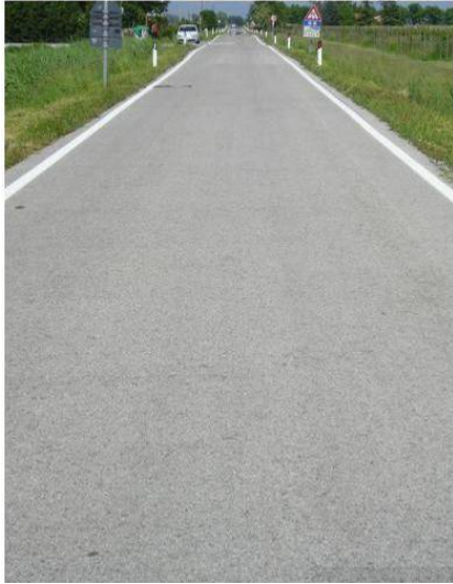
Figura 2-12 Visione di insieme della pavimentazione stradale armata con rete elettrosaldata
