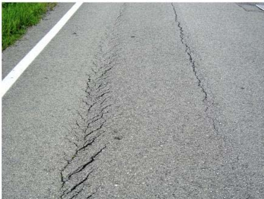
Figura 2-40 Frattura a pelle di cocodrillo
