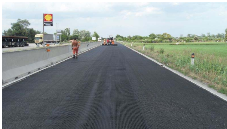
Figura 4-40 Ultimazione posa in opera geocomposito
