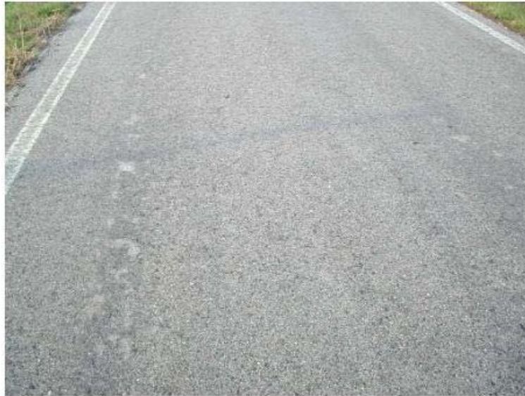
Figura 2-11 Visione d'insieme del tratto stradale armato con rete elettrosaldata che si presenta omogeneo e non interessato da particolari dissesti
