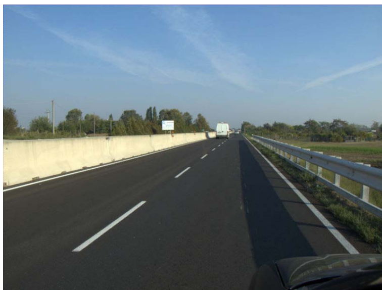
Figura 4-48 Ispezione visiva del 25 settembre 2009
