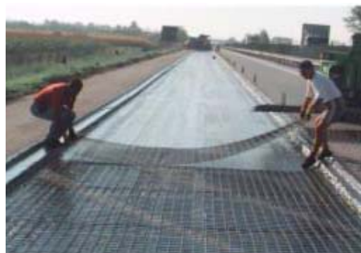
Figura 2-20 Posa in opera della rete elettrosaldata
