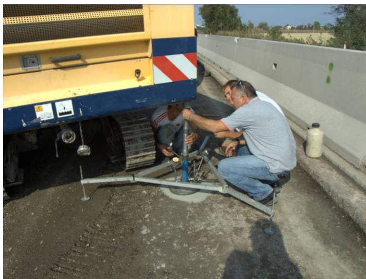
Figura 4-21 Prova di carico con piastra
