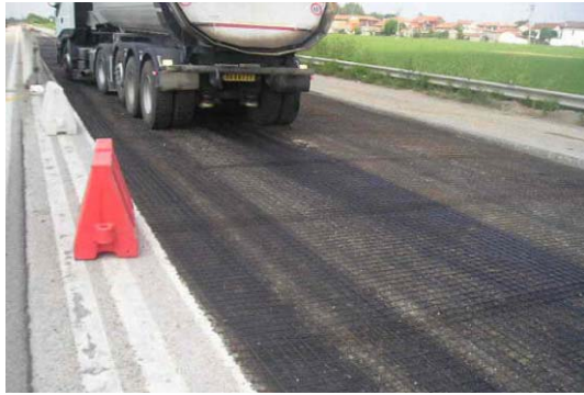
Figura 4-29 Seconda mano d'attacco con emulsione bituminosa
