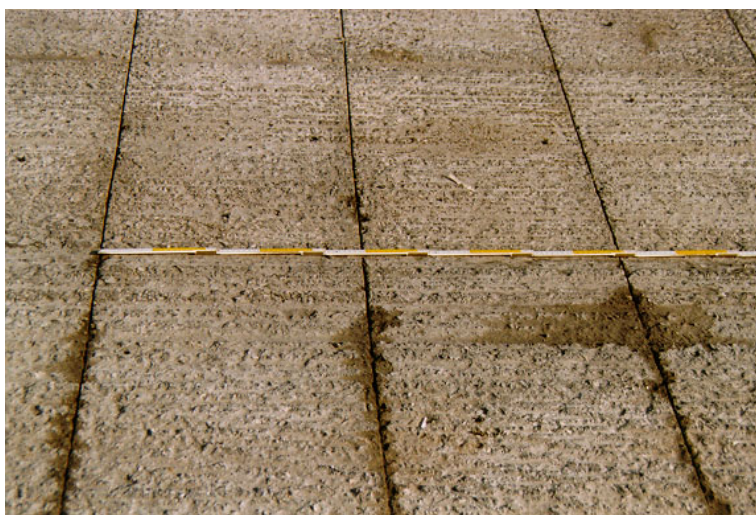
Figura 2-53 Preparazione del campo prova: realizzazione dei solchi
