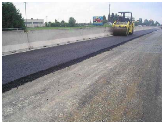
Figura 4-32 Compattazione prima stesura del conglomerato bituminoso
