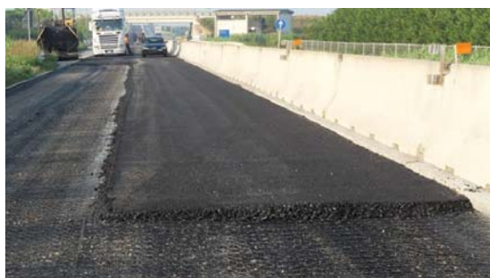
Figura 4-38 Strato di conglomerato bituminoso steso sulla rete
