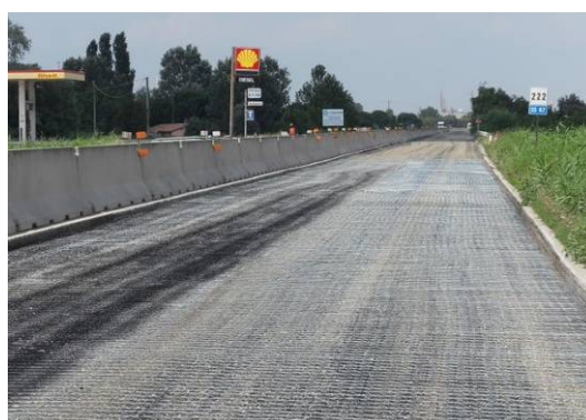
Figura 4-37 Stesa della rete Road Mesh
