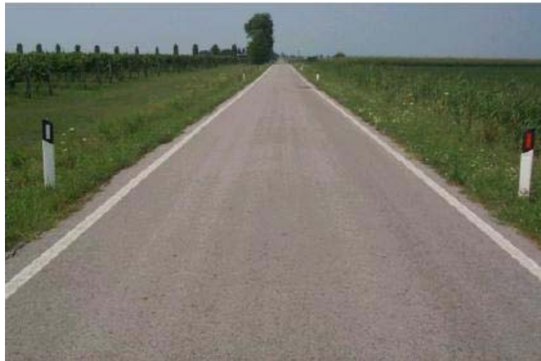
Figura 2-8 Visione d'insieme del tratto stradale armato con rete elettrosaldata che si presenta omogeneo e non interessato da particolari dissesti.
