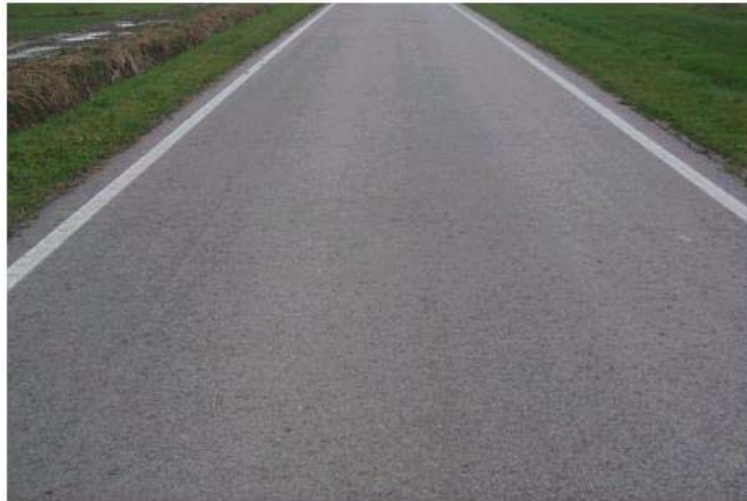
Figura 2-5 Aspetto della pavimentazione armata con rete elettrosaldata
