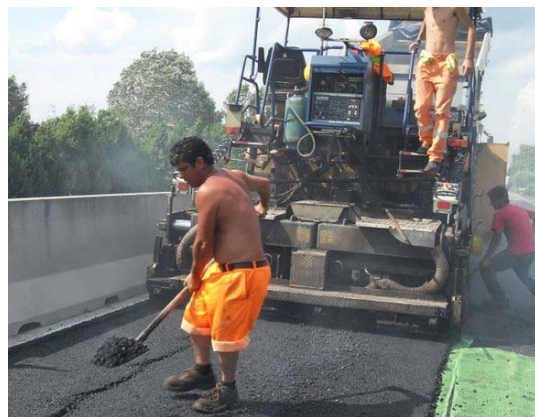
Figura 4-47 Riparazione fessure con aggiunta di materiale
