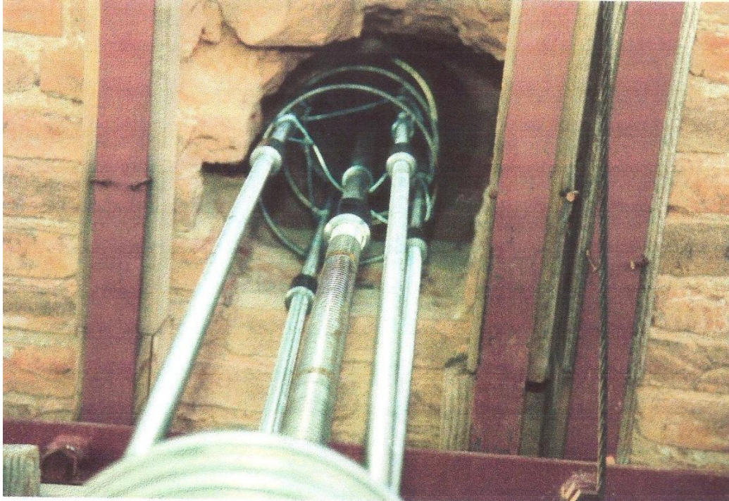
12. 6 Posa in opera di nuove catene
