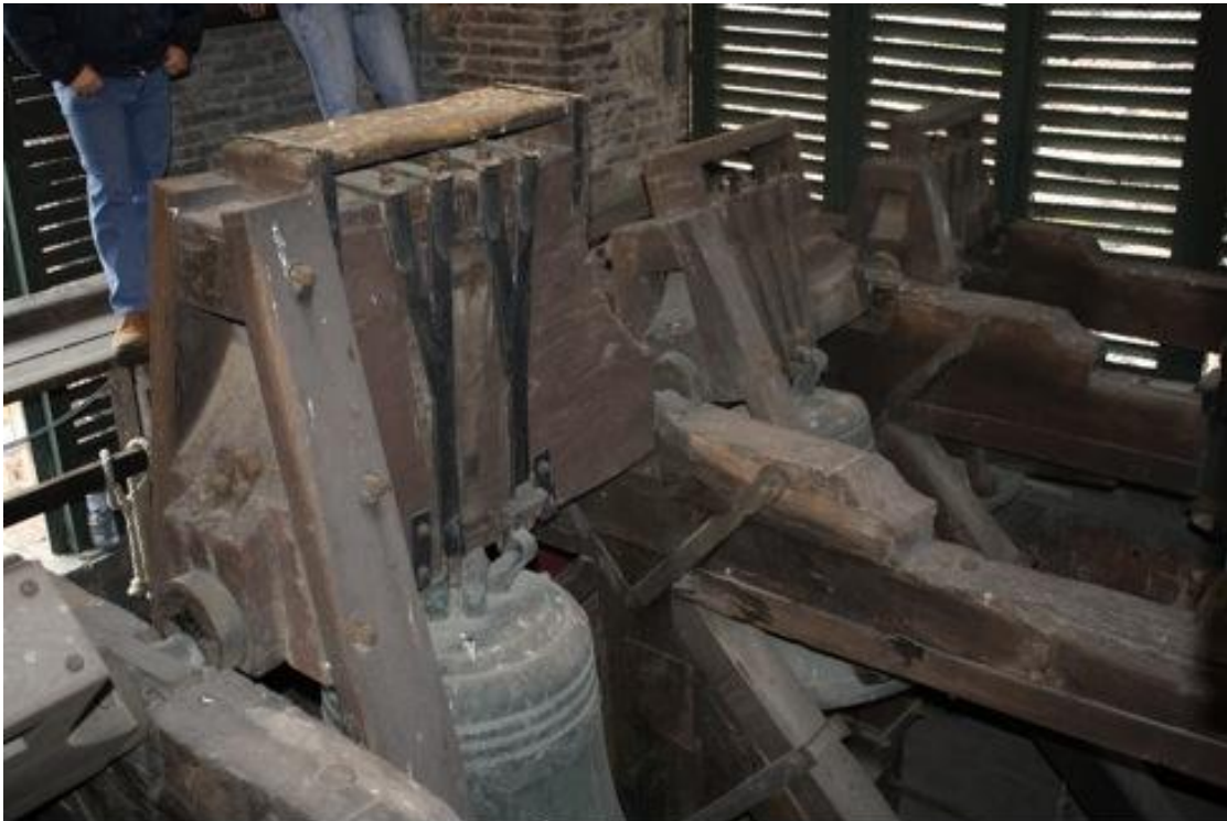
Vista interna della cella campanaria
