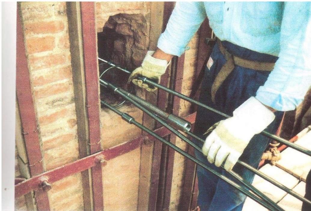
12. 7 Posa in opera di nuove catene all'interno dei carotaggi, particolare della filettatura
