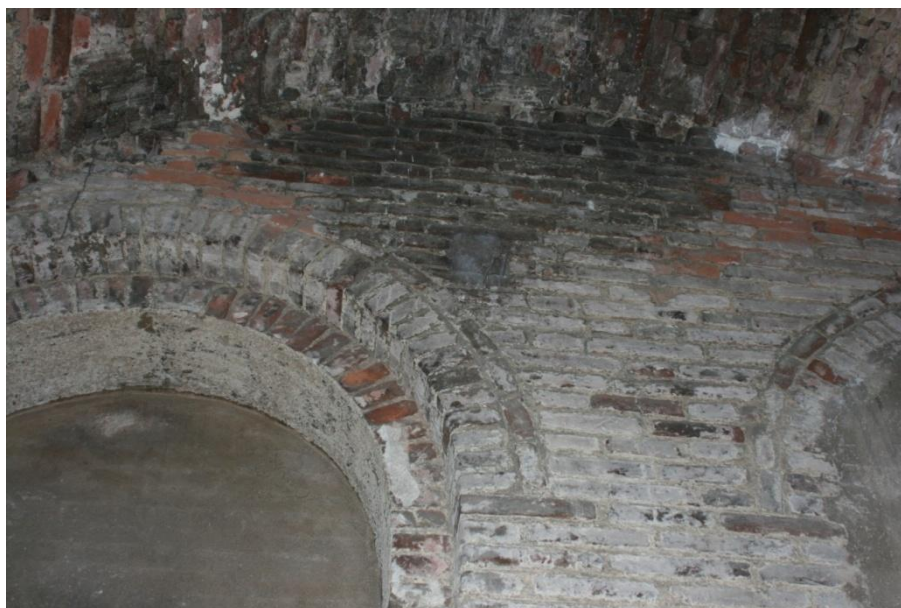
2. 37 Segni del ripristino dei paramenti effettuato al di sotto della volta a crociera sottostante la cella campanaria in vicinanza delle aperture
