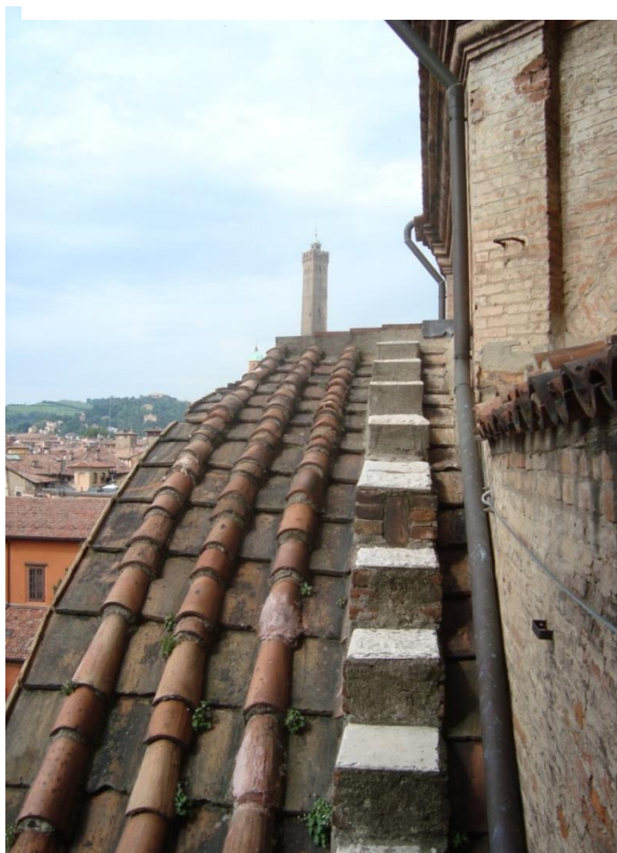
2. 14 Vista dell'arco su cui grava la cupola sopra l'altare principale dall'apertura presente sul paramento murario 14 del campanile
