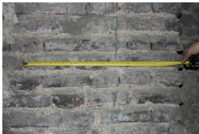
4. 2 Paramento murario interno del campanile nel vano di accesso
