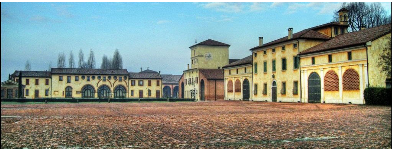
Fig.(17) Corte Costavecchia, San Giorgio, MN, [da www.panoramio.com ]
