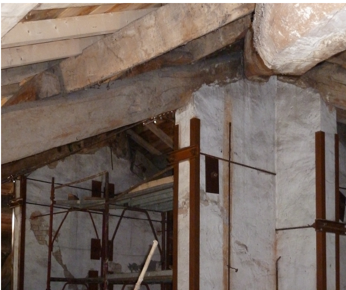
Fig.(111) Sottotetto Villa Arrigona, Moglia, Mantova.
