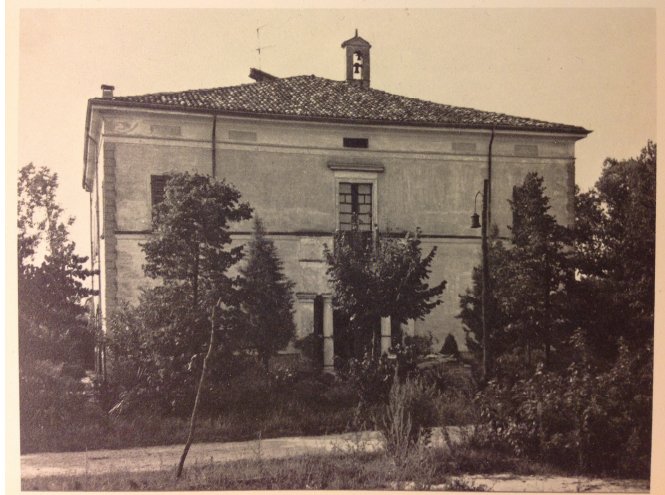
Fig.(79) Villa Nievo Prospetto Principale
