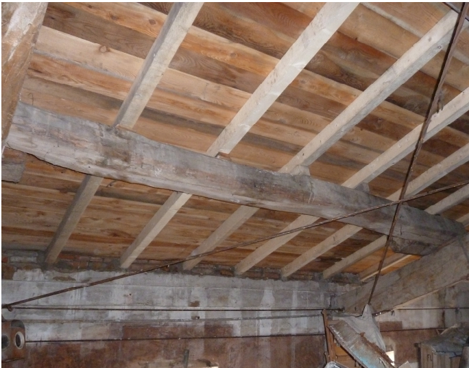
Fig.(110) Solaio di copertura Villa Arrigona, Moglia, Mantova.
