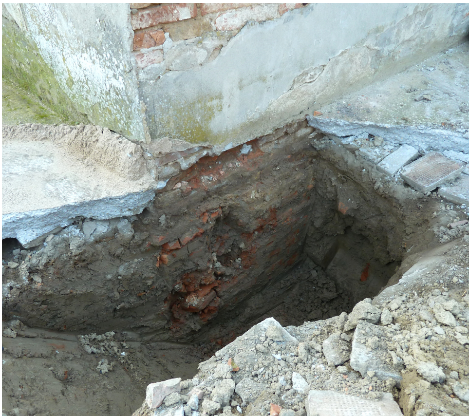
Fig.(115) Saggio sulle fondazioni, Villa Arrigona, Moglia, Mantova
