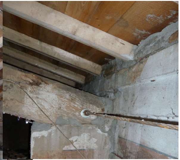
Fig.(112) Sottotetto Villa Arrigona, Moglia, Mantova.
