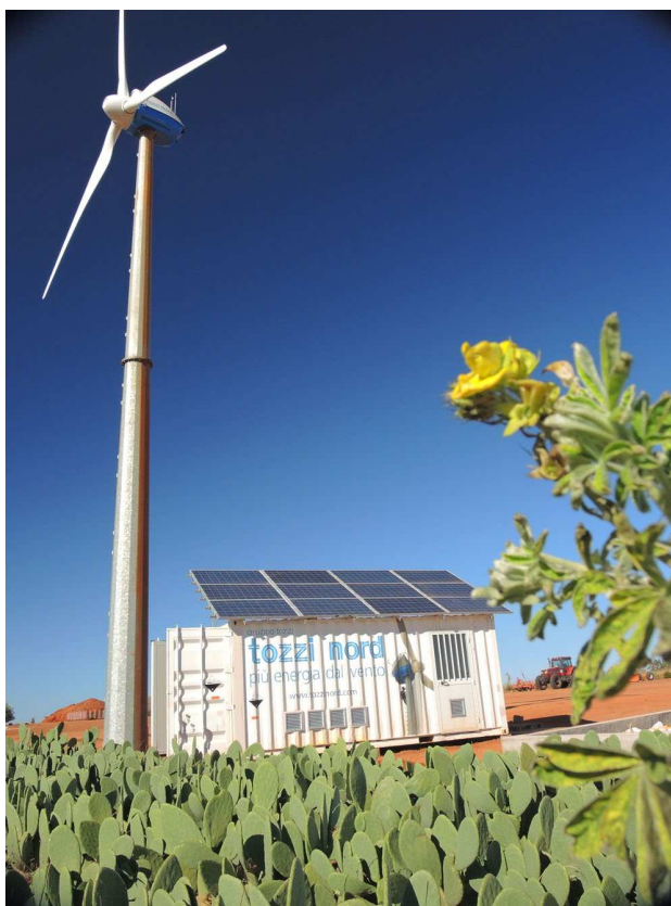
Figura 5.1: Installazione del locale tecnico e dell'aerogeneratore.
